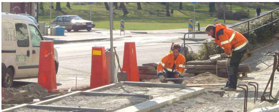
Figur 5.13 Två arbetare på anläggning som diskuterar hur ett visst moment ska utföras
