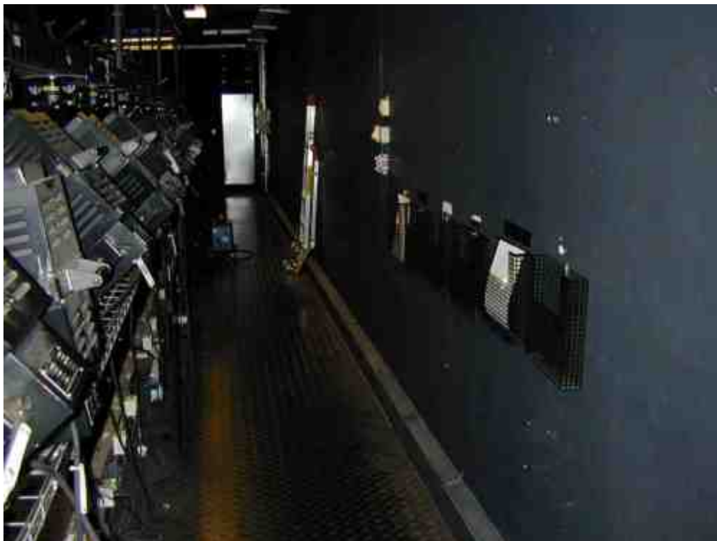
Bild 3. Högra sidans teknikbalkong, till vänster i bild syns baksidan av lamporna som är riktade ner mot scenen. På väggen, till höger i bild, hänger korgar med föreställningsdokumentation.
