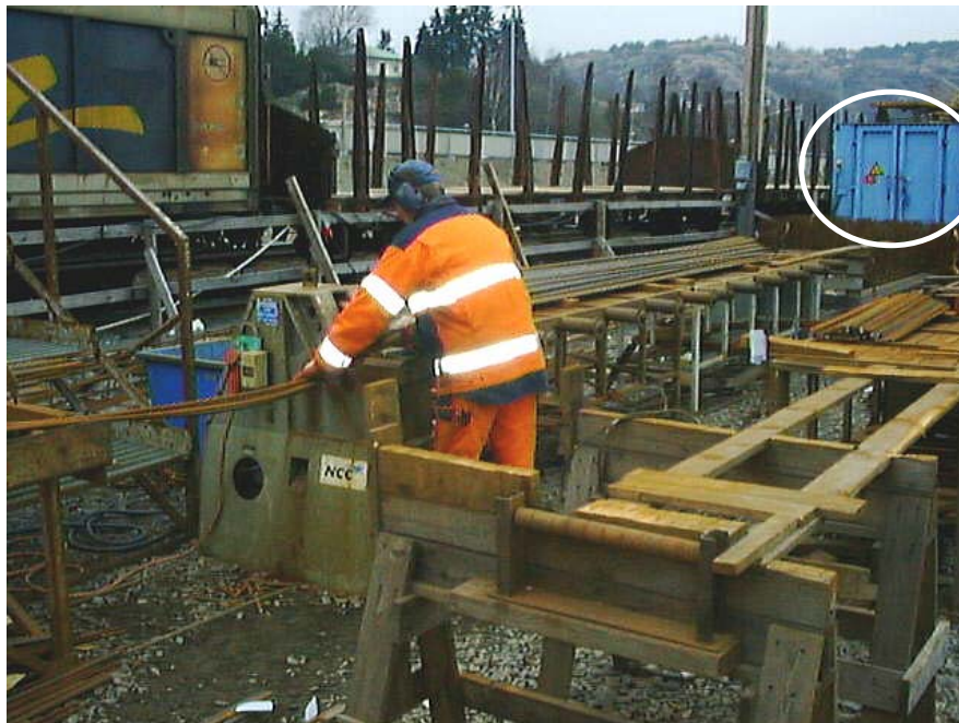
Figur 7. Armeraren färdigställer armering genom att kapa och bocka till armeringsjärnen. Den inringade delen visar på containern där ritningar och arbetsinstruktioner förvarades.
