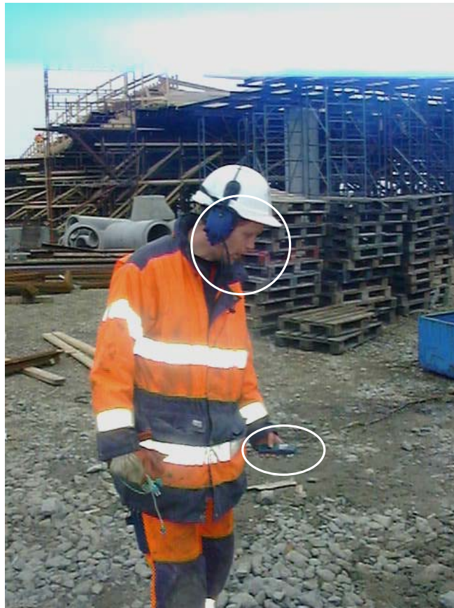
Figur 4. Bilden visar hur arbetsledaren använder sig mobiltelefon tillsammans med en inbyggd mikrofon kopplad till hörselskydden.
