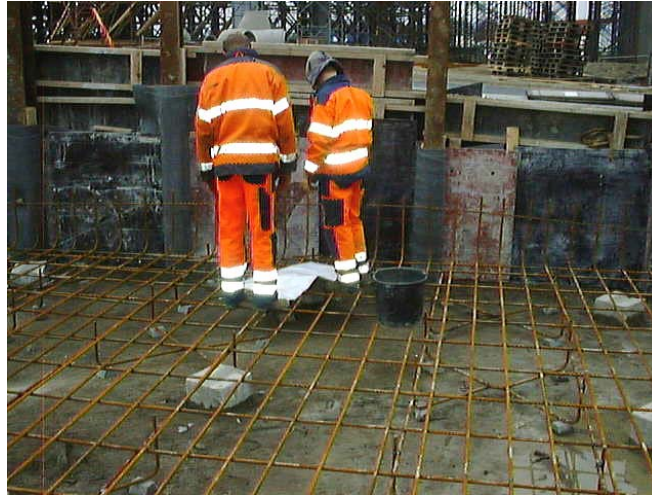
Figur 9. Två armerare står över en ritning som ligger i närheten av där arbetet bedrivs.
