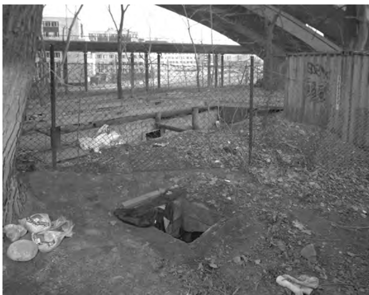
BILD 30 Inledningsbild till scenen Vattenledning .
