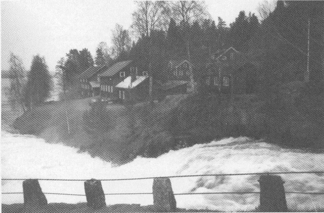
Fig. 6.4. Ränkeforsen så som den ter sig idag vid fullt vattenpåsläpp vid Lennartsfors kraftstation. Foto C. Heimann år 2000.
