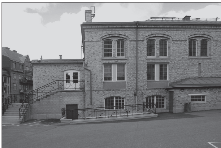
Bild 5: Matsalsbyggnaden på Internationella skolan
