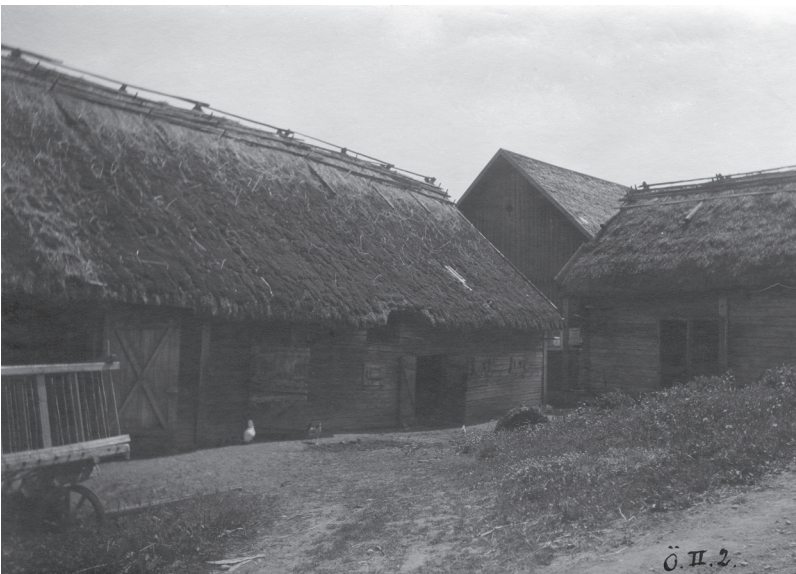
FIGUR 28. Emil Johanssons ekonomibygnader sedda från motsatt håll. Här skymtar även Jonas Petter Lööfs nybyggda ladugård med sticktak och gavel av regelverk.
