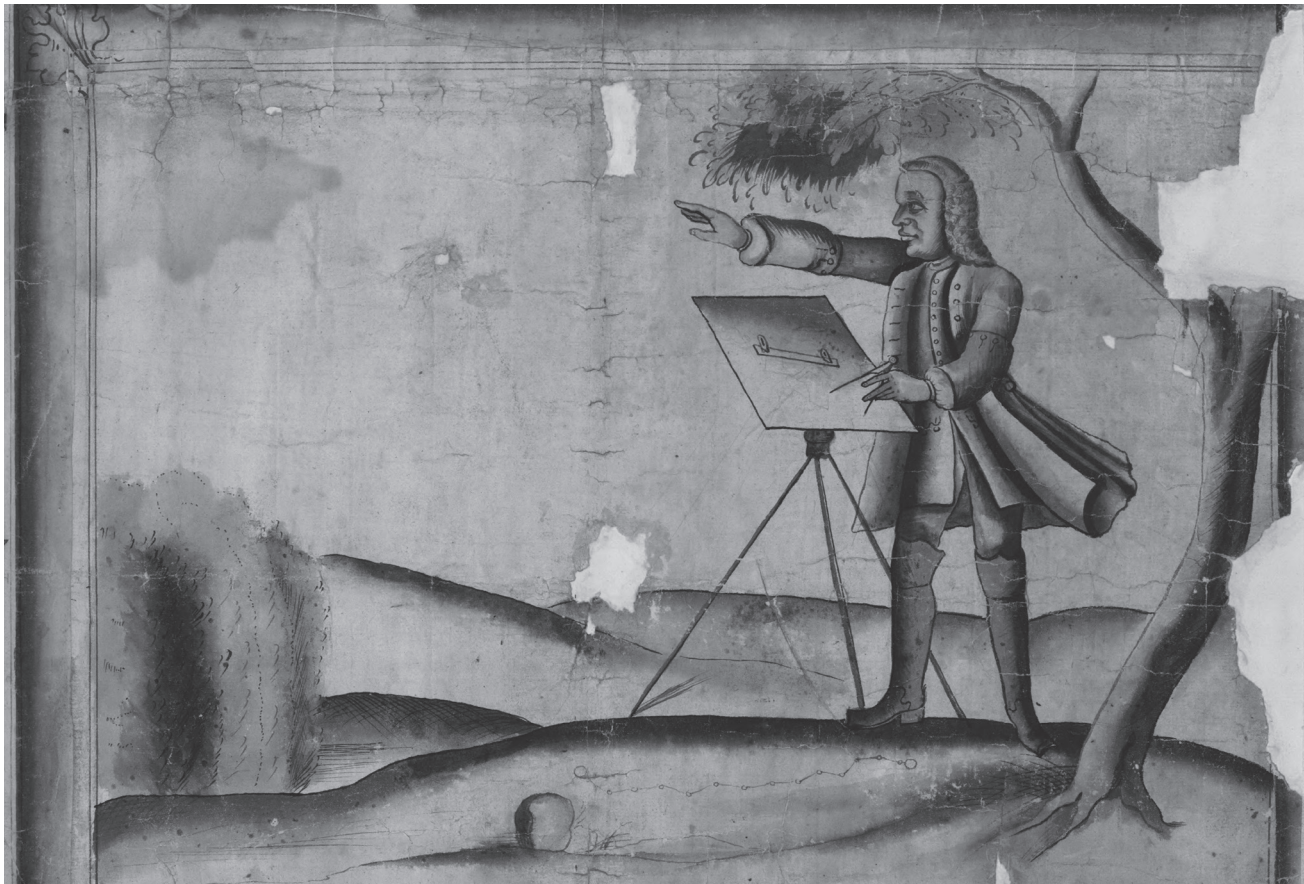
FIGUR 12. Mätningen vid en lantmäteriförrättning krävde stor noggrannhet. Kartan ritades upp på den s.k. lantmätartavlan – ett horisonterat mätbord stående på tre ben. Ovanpå den syns den s.k. diopterlinjalen med olika skalor och i handen har lantmätaren en passare. På marken ligger mätkedjan som skulle vara ”af jern med ett qwartern eller half alns länkar och 25 alnars längd”, enligt lantmäteriinstruktionen 1827. Denna kartillustration skapades av en småländsk lantmätare 1735.
