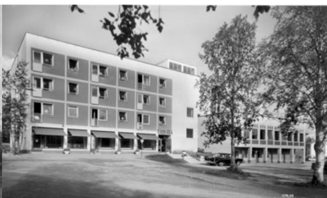
Fig. 12 Det nya hotellet fotograferat år 1958. Grönytorna i Fig. 11 är ersatta av en ny parkyta.
