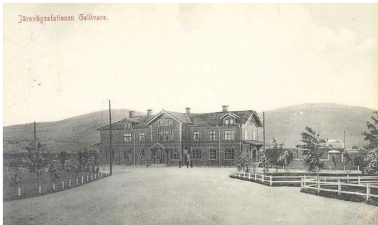
Fig. 7 Järnvägsstationen. Ytterligare ett antal år har gått sedan trädplanteringen gjordes i Fig. 6.
