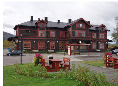
Stationsbyggnaden sedd från öst
