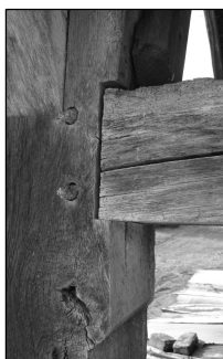
Figur 44: (ST AD) En tap med hus forekommer ved det horisontalt bærende tømmer, hvor man har tilføjet ca 2,5 cm i hver ende af tømmeret. Her har jeg ikke fundet nogen ridser på tapstykket, da man sandsynligvis har taget højde for denne forlængning af tapstykket allerede ved opmærkningen og ikke har ønsket to linjer til at forvirre ved tilvirkningen af tappen.
