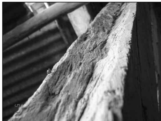
F – Udhugning til lerfyldning fra FT i laden (se bilag I-2-E)
