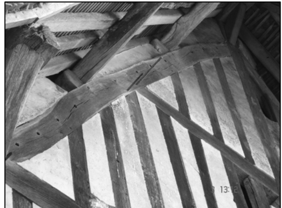
D - Østgavlens krogede spær med "taphulsstigen"
