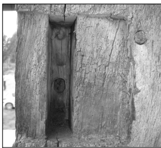
Figur 52: Taphullerne har givet ret god information om tilvirkningsprocessen, da jeg i bunden af de fleste taphuller har fundet små runde huller. Det har jeg tolket således at man først har boret huller for at fjerne materiale, og dermed gjort det lettere efterfølgende at skære hullet firkantet med bisaigue eller stemmejern. Hullet tyder på at boret hverken har haft skruegevind eller nogen anden form for spids. Før man har kunnet begynde at bore, har man været nødt til at starte hullet med et rundt stemmejern eller måske endda med nogle hug med en bisaigue.
