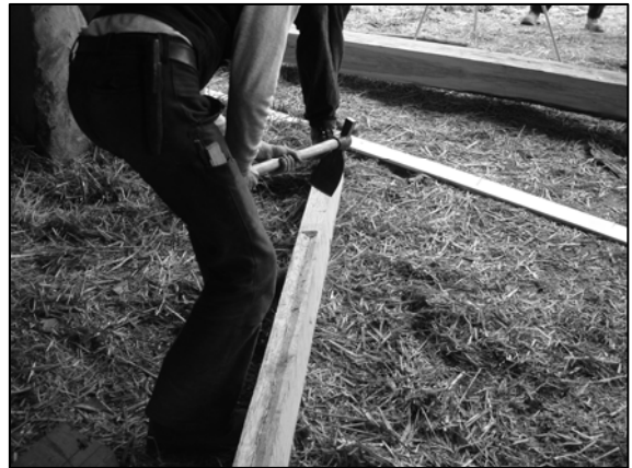
D – Udhugning til lerfyldning med "herminette"
