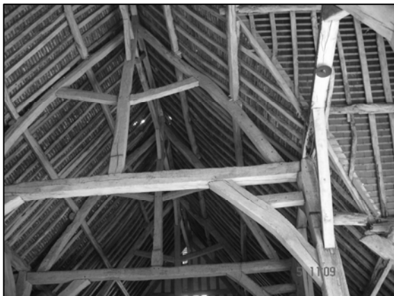
E - Ladens stolpeværkskonstruktion
