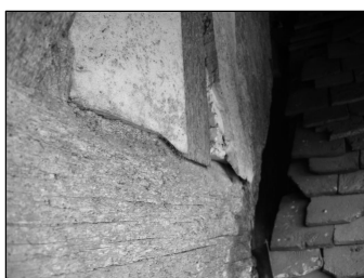
Figur 47: (FT D 1) Når tømmeret allerede har været uregelmæssigt under opmærkningen har man enkelte steder været nødt til at lave det såkaldte skæg. Man har tilføjet materiale på tapstykkets brystning for at kompensere for rundingen på taphulsstykket (se figur 48 og bilag I-11-G). Her på FT D 1 har jeg fundet ridser på selve skægget som viser opmærkningsteknikken
