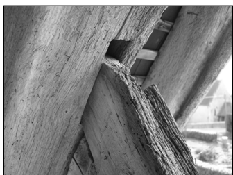
Figur 46: (FT A 11) - (se bilag I-11) Den såkaldte bastard-tap er en almindelig tap hvor man har forskudt tapmaterialet, så man kun har skullet lave brystning på tapstykkets forside (se bilag I-10-E og I-11-F). Denne taptype har besparet en del arbejde i tilvirkningen af tapperne, og da fyldtømmeret som oftest ikke har haft nogen vigtig bærende funktion har der ikke været nogen grund til at lægge unødigt meget arbejde på disse. Næsten alt FT er lavet med bastardtap. (undtagelser se bilag I-3-I).
