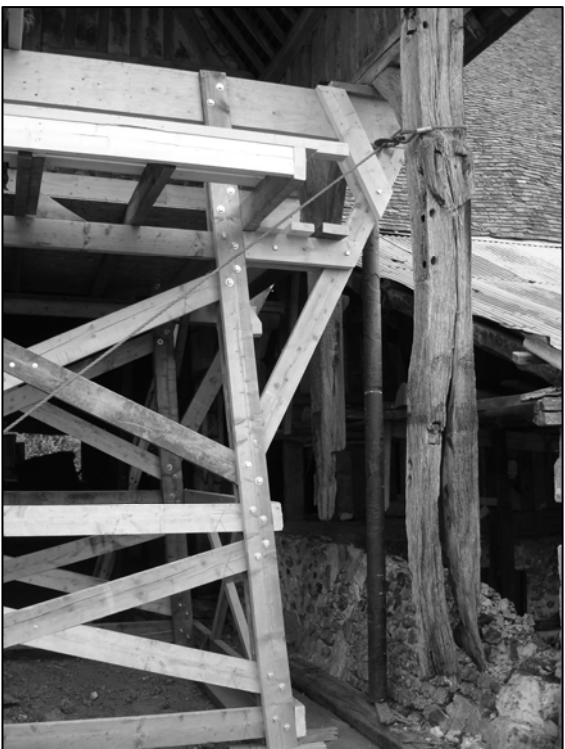
E – Stillads og løfteanordning til restaurering
