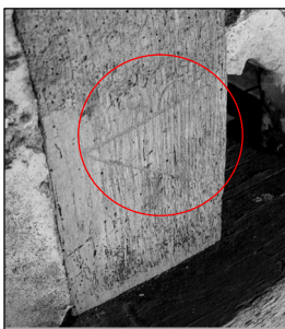
Figur 51: På væg C findes der nogle tydelige mærker efter nummereringen (se bilag I-5-I). Der findes imidlertid ikke så mange spor efter nummereringen andre steder i selve indgangspartiet, hvilket sandsynligvis skyldes at træet har været udsat for vejr og vind igennem 500 år og nummereringen har fundet sted på ydersiden, den öbindigeö side.
