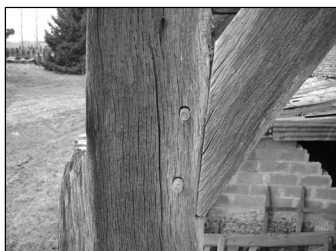
Figur 45: (ST AD) De fleste af skråbåndene har fået tilføjet en ansats som et ekstra støttepunkt hvor skråbåndet er tappet ind i stolperne. Her har jeg flere steder fundet vertikale ridser som viser hvor samlingen ville have været uden ansatsen
