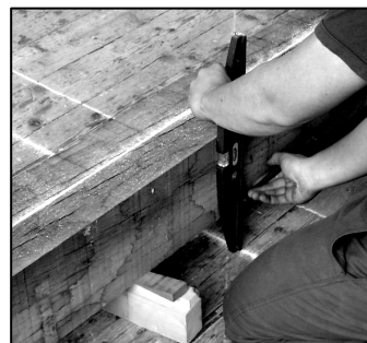
Referencehøjden markeres på alle hjørnestolper.
