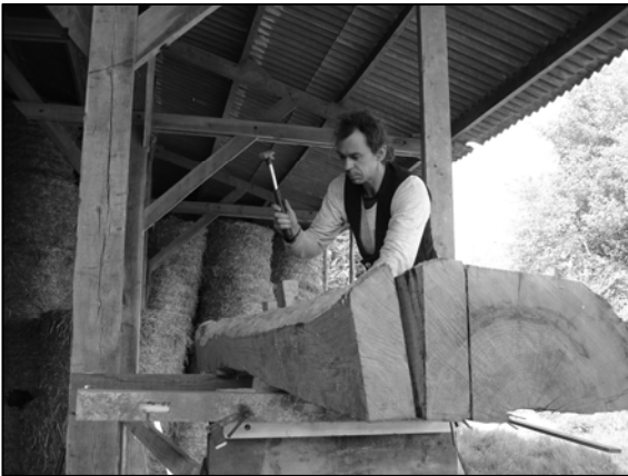
C – Fyldtømmer sprækkes løs med kiler (Axel Weller)
