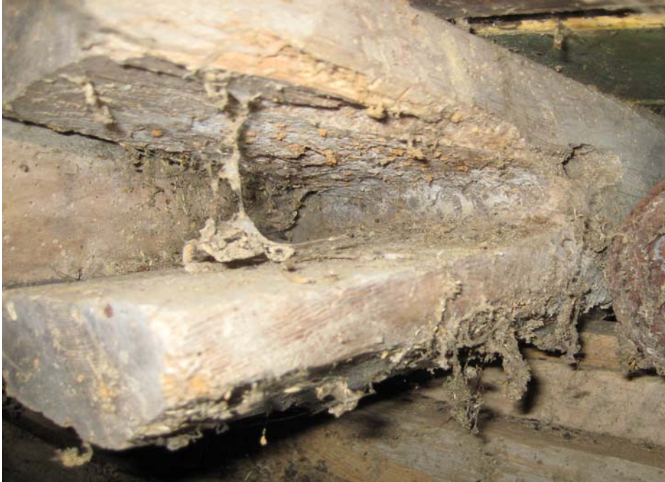
Fig. 36. Detalj av klauv i sperretoppen, tatt ut med 1 toms kona naver, og øks. Foto S.N. Mars 08.
