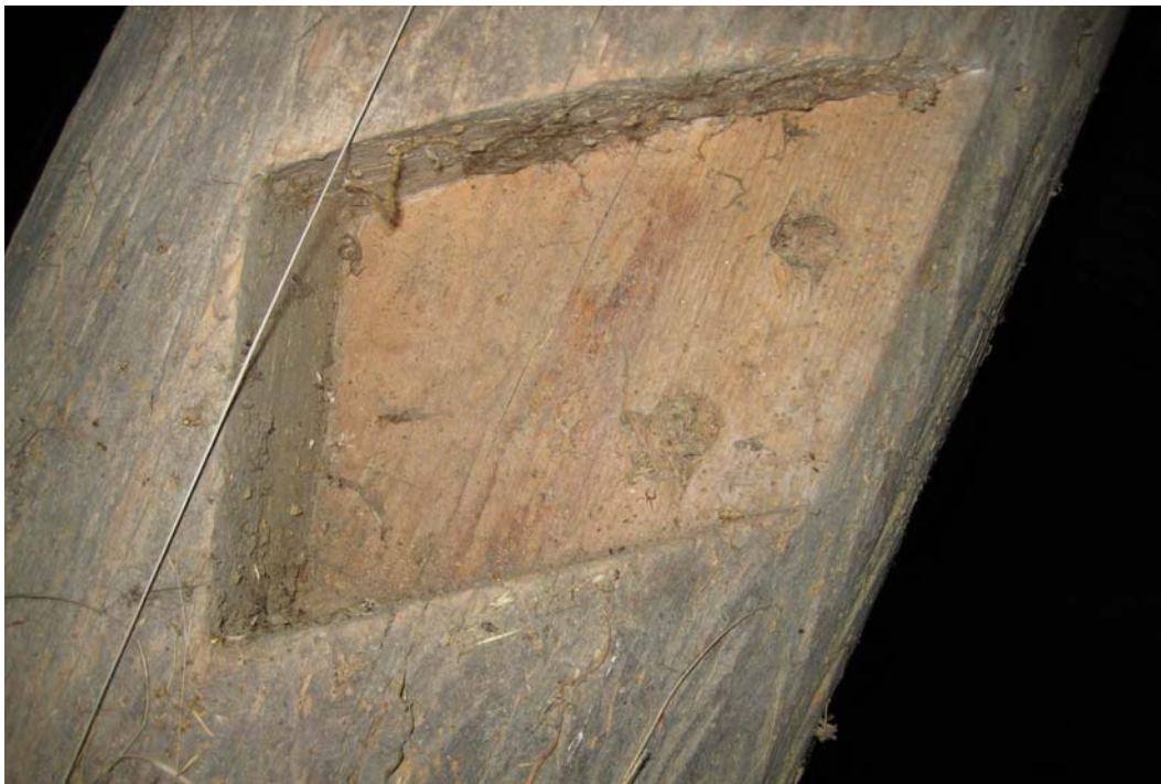
Fig. 7. Stav 1 innfelling for skråband med to mindre dymlingshull. Foto S.N. Feb.08.
