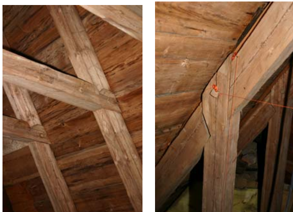
Hopfogningarna i Torpa kyrkas gotiska takkonstruktion har ”nacke”, foto C. Thelin 2005.
