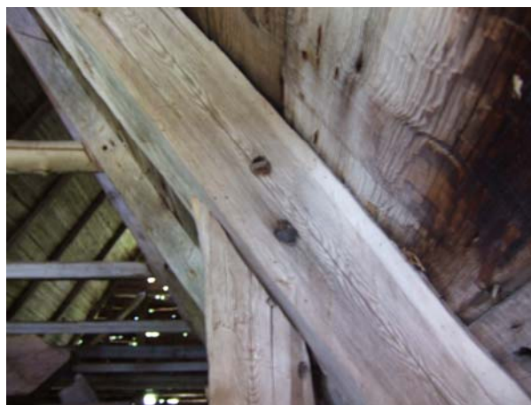
Kyrkås kyrka, senmedeltida taklag med återanvända sprättäljda trobrädor, foto P. Jarefjäll 2007.
