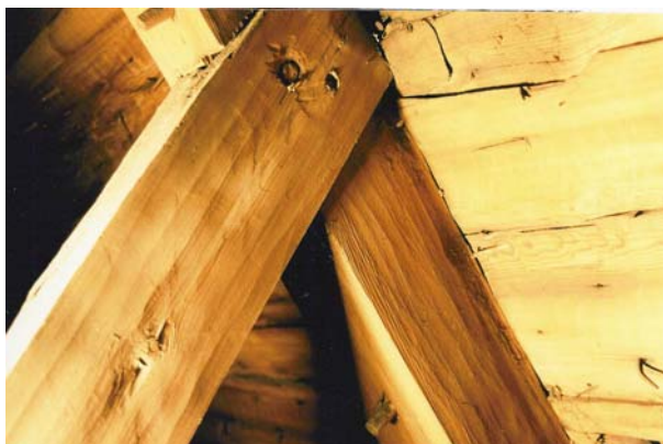
Spåren efter hyvling med skave på sparrar i Högs kyrka. Foto B. Björck, 1999.
