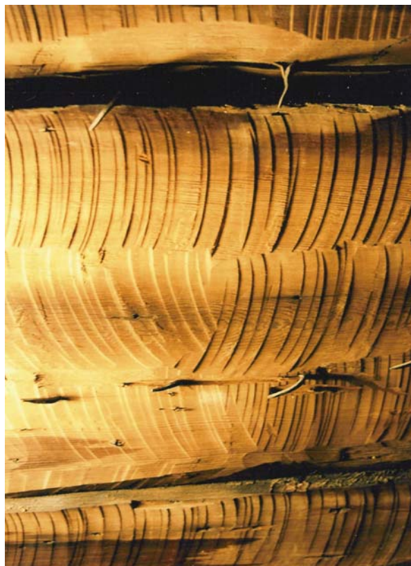
Sprättäljning på underlagstaket, ”trobrädorna”, i Högs kyrka. Foto B. Björck, 1999.
