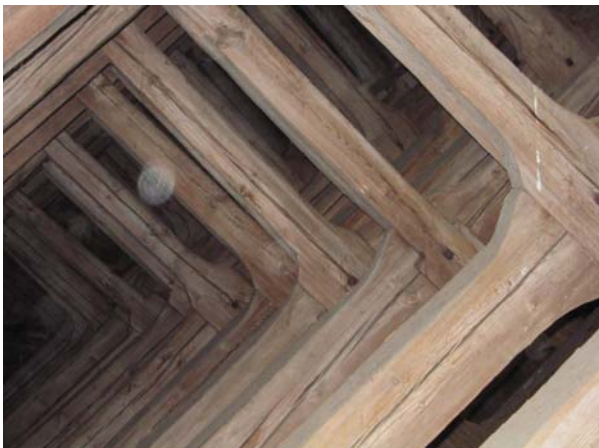
Dymling av furu, täljd som en smidd spik med bred skalle, i Torpa kyrka, foto C. Thelin 2005.
