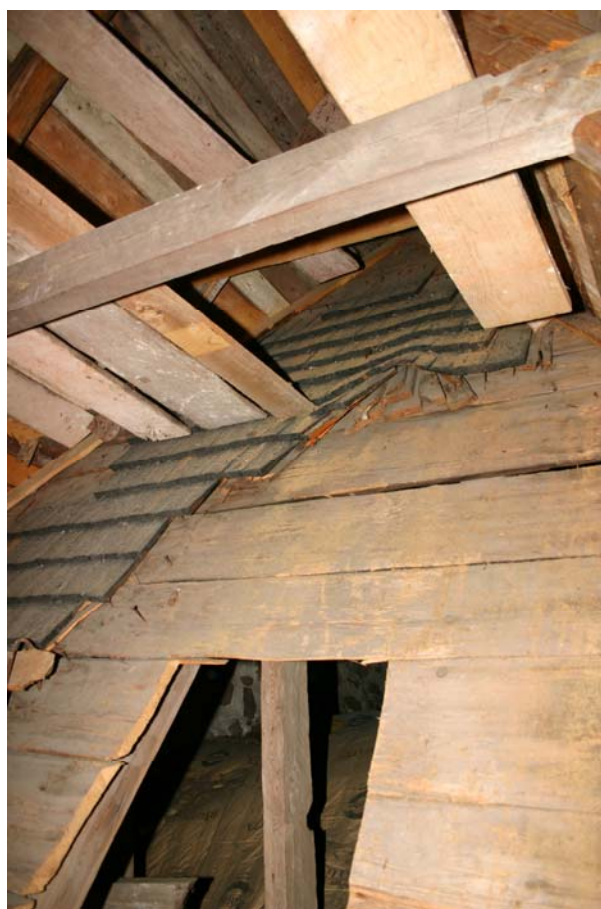
Underlagstak och bevarade medeltida spån i Torpa kyrka, foto C. Thelin 2005.
