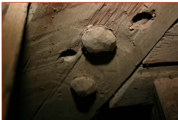
Dymling av furu, täljd som en smidd spik med bred skalle, i Torpa kyrka, foto C. Thelin 2005.
