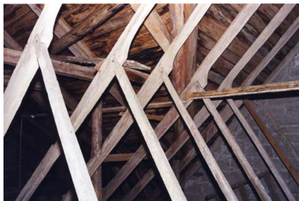
Romanska takstolar med enkla stödben finns t ex i Forsbems kyrka (till vänster) och romanska takstolar med korsande stödben finns t ex i Marum kyrka (till höger). Ritning P. Sjömar, 1995.
