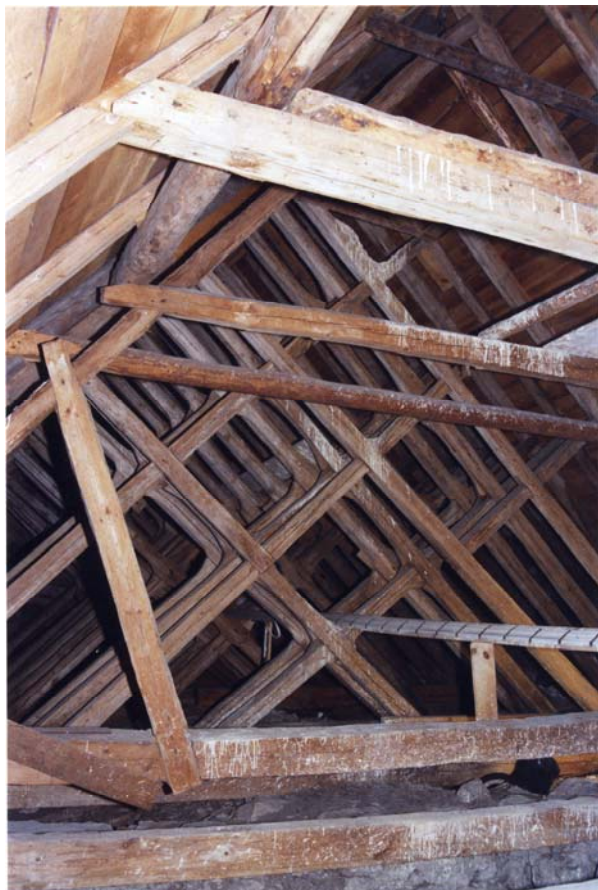
Gökhemskyrkan i Västergötland, långhusets taklag med bindbjälke och flera stödben är sannolikt rest före 1150, foto C. Thelin 2005.
