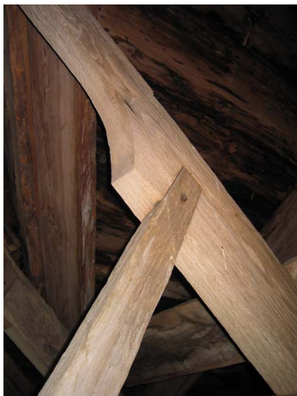
Stödbenen har i vissa kyrkor dekorativa element som t ex i den smäckera sammanfogningen mellan stödben och sparre i Forsbems kyrka. Hopfogningen är låst med en smidd spik. Takstolarna står glest utplacerade över vinden. Taklaget är dendrokronologiskt daterat till 1135. Forsbems ligger några mil norr om Skara. Foto C. Thelin 2005.
