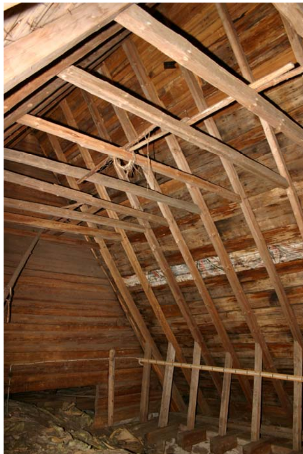
Torpa kyrkas senmedeltida taklag höjer sig högt ovan valv och murkrön och har knäbock och banbjälke, foto C. Thelin 2005.
