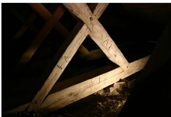
Märkning är inte funnet i något av de allra äldsta taklagen från 1100-talet, men förekommer i senare romanska konstruktioner, som här i Hemmesjö kyrka, foto C. Thelin 2005.
