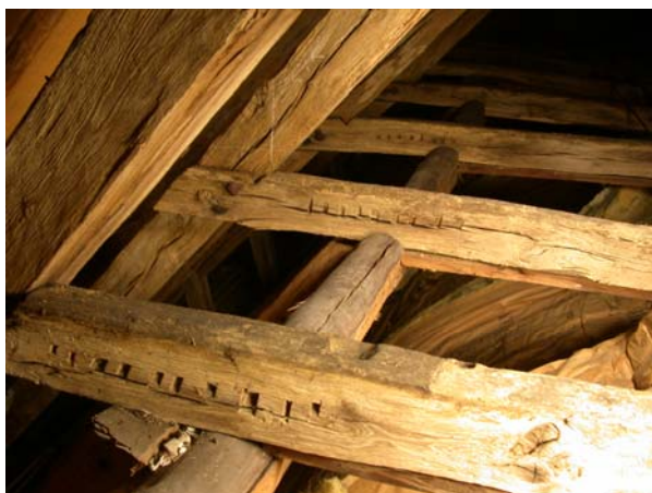
Taklaget i Torslanda kyrka liknar norska taklag och är sannolikt ett enstaka exempel på en särskild västsvensk romansk takstolstyp, foto J. Storm 2005.
