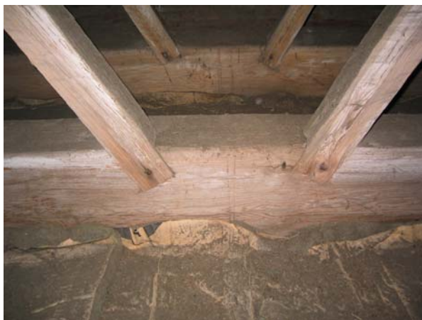
Mötet mellan bindbjälke och stödben i Jäts gl kyrka, foto C. Thelin.
