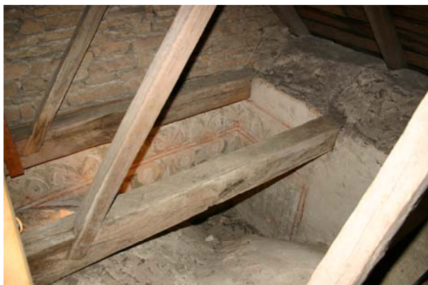
Kaga kyrka, ovan valvkapporna finns de ursprungligen synliga takstolarna bevarade tillsammans med väggmålningar som är äldre än valven. Foto C. Thelin 2005.
