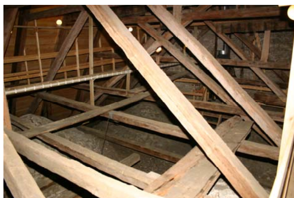
Fole kyrkas gotiska taklag med uppstickande valvkuapor, foto C. Thelin 2005.
