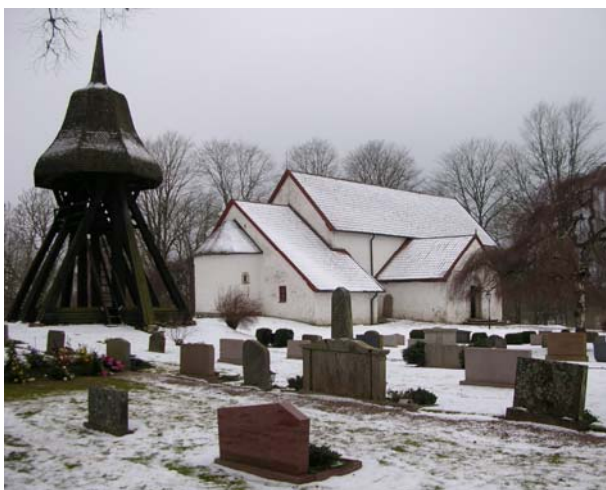
Gökbeams kyrka med ursprungligt romanskt taklag, har en ganska flack takvinkel, foto K. Linscott 2006.
