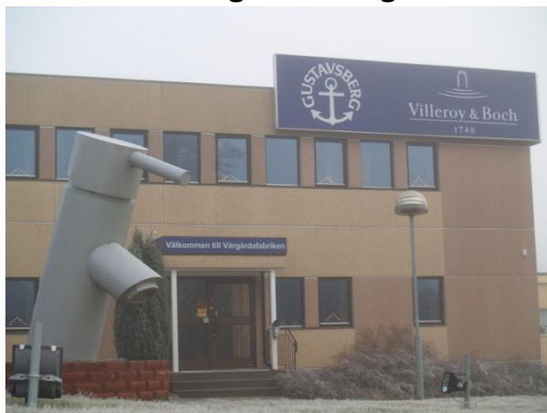
Bild 8: Egen bild, Vårgårdafabriken.
