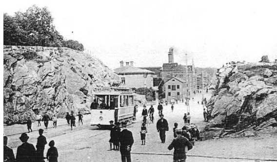
Figur 34. Spårvagnsspåret nyanlagt. Det här är den nyskapade skärningspunkten mellan Allmänna vägen och Karl-Johansgatan. Man kan själv med ögat förbinda knallen till höger med det utsprängda berget till vänster, som Karl-Johanskyrkan står på. Om inte mer berg sprängdes bort torde Stenparkens murar och stödmurar ha anlagts på denna knalle. ((D.50.958 GMA)
