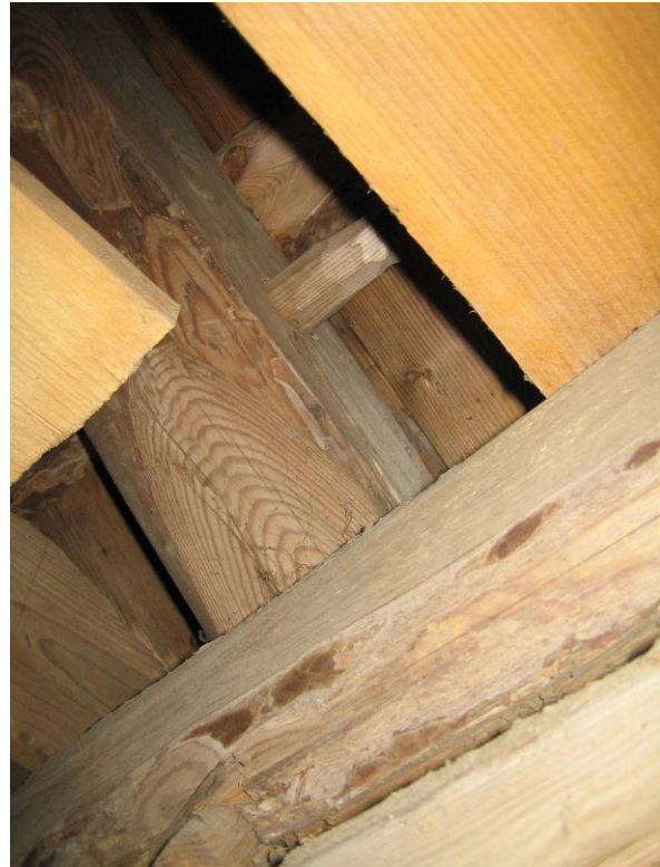
Figur 3. Dymling som fortfarande sitter i mallen (loge Dyrenäs)
