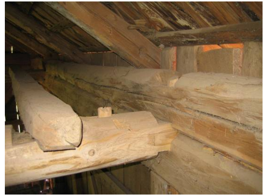
Undre bindbjälke intimrad med en halv lax halv lax. Haket där den övre bindbjälken var intimrad syns på övre hammarbandet.
