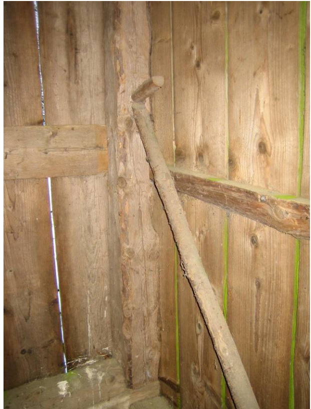
Figur 27. Liten lada i Lugnås. Sträva och dymling
