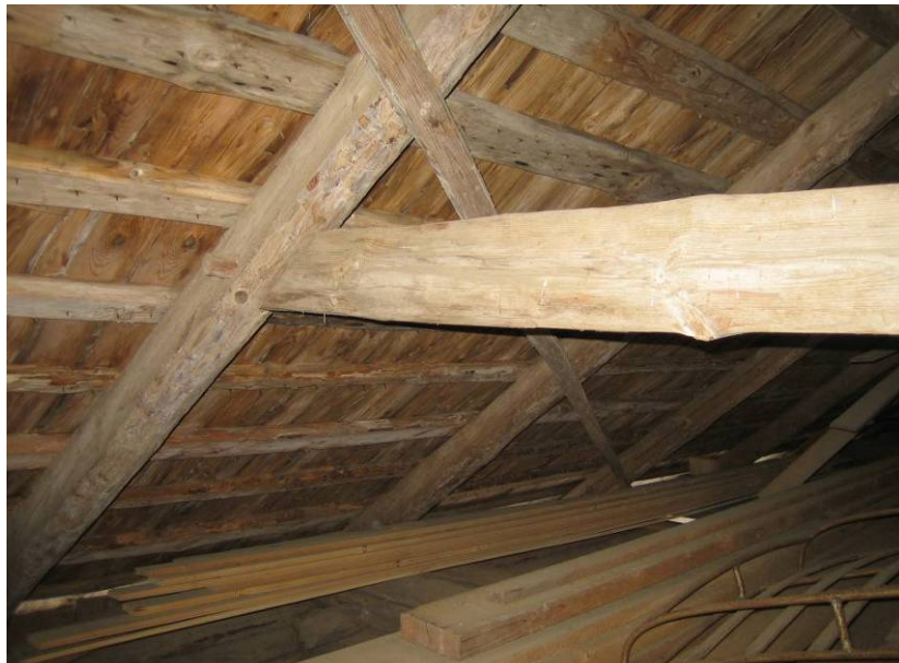
Figur 28. Takkonstruktionen i ladan i Dyrenäs.
