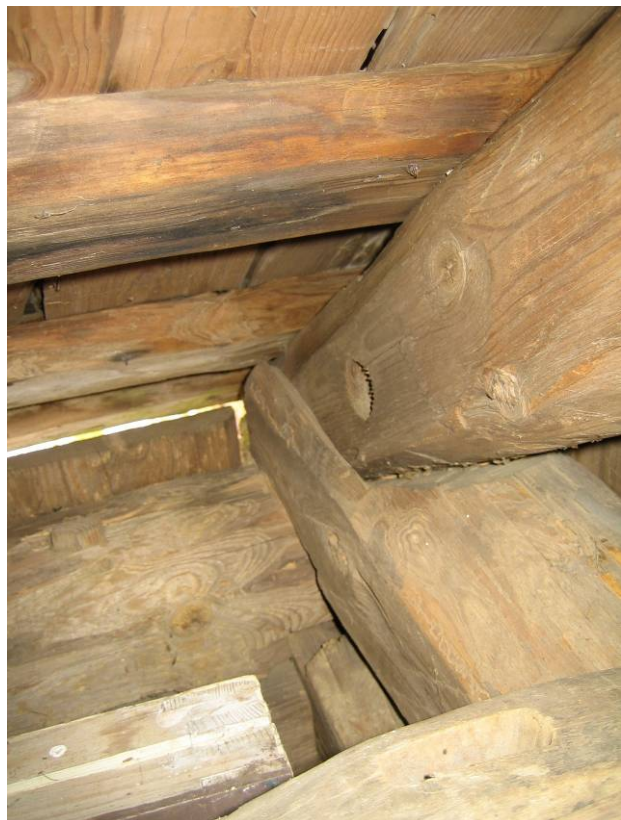
Mötet mellan stolpe hammarband och bindbjälkar
