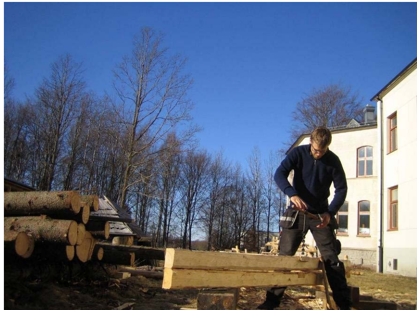
Figur 13: Hanbjälken fästs med en dymling
