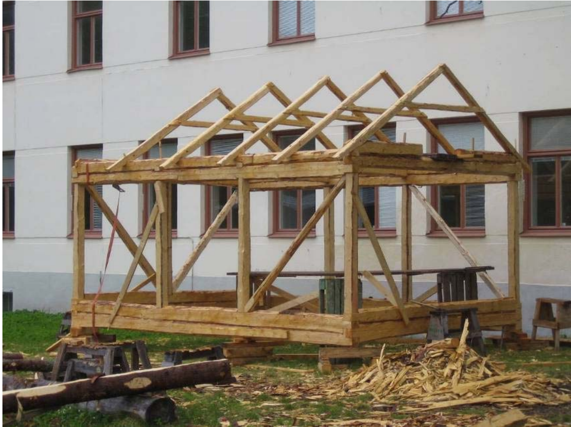
Figur 29. Stommen är klar. Alla takstolar har monterats utom malen.
