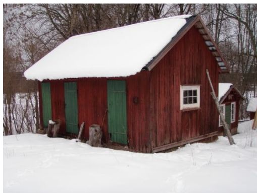
Fig. 22 Visthusboden med källare
