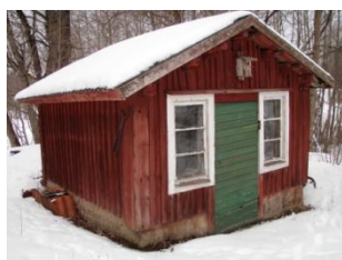
Fig. 23 Ekonomibyggnaden nordöst om visthusboden
