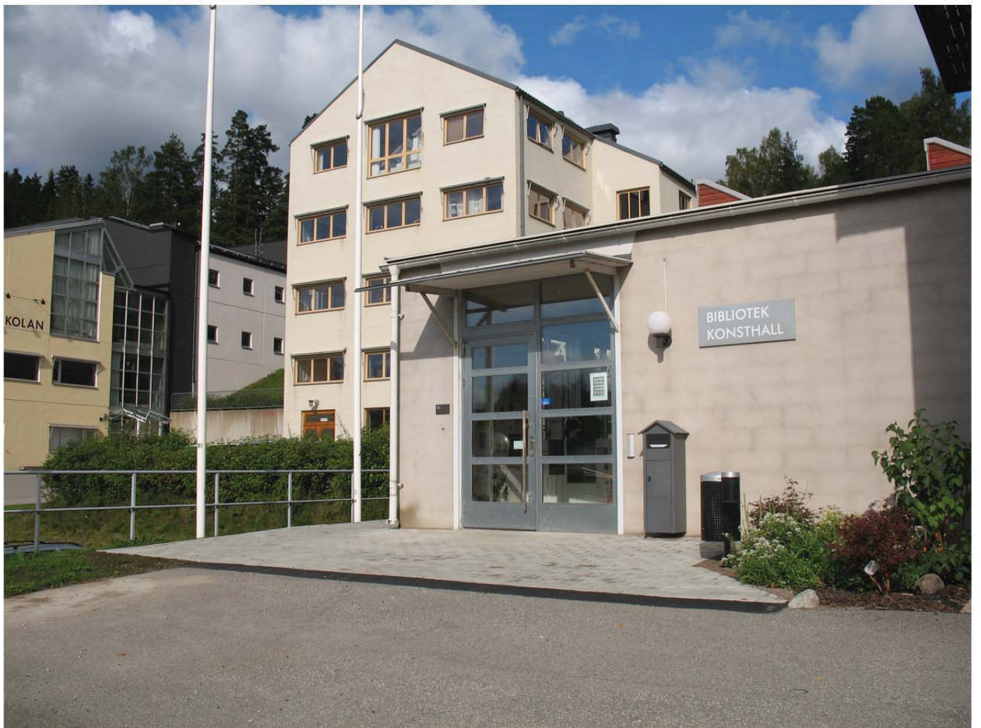
Ny markbelägning vid bibliotekets entré.
