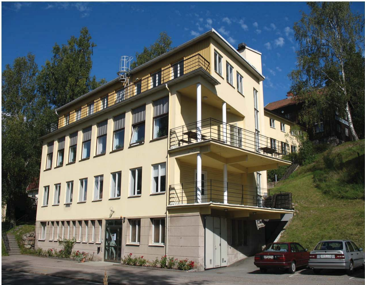
Plats 2. Etapp 3. Funkishuset. Skolans huvudbyggnad.
