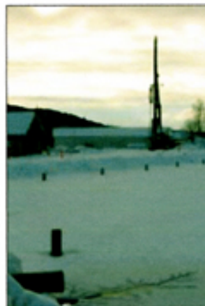
Plantar för bryggan har anlagts längs med strandkanten vid sjödoden. Foto: Annelie Leberg
