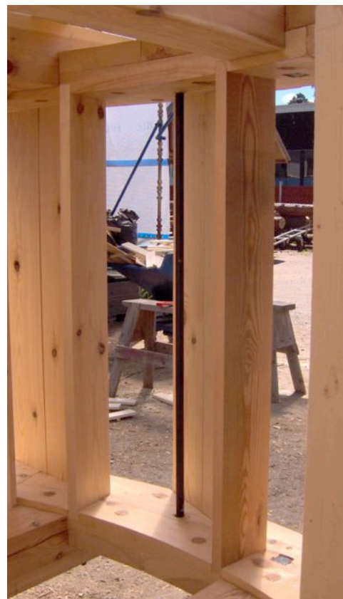
4. Gjennomgående stang for sammenpressing av sidestykker.
