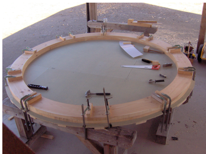
3. Begge løtringene ferdigtilpasset
