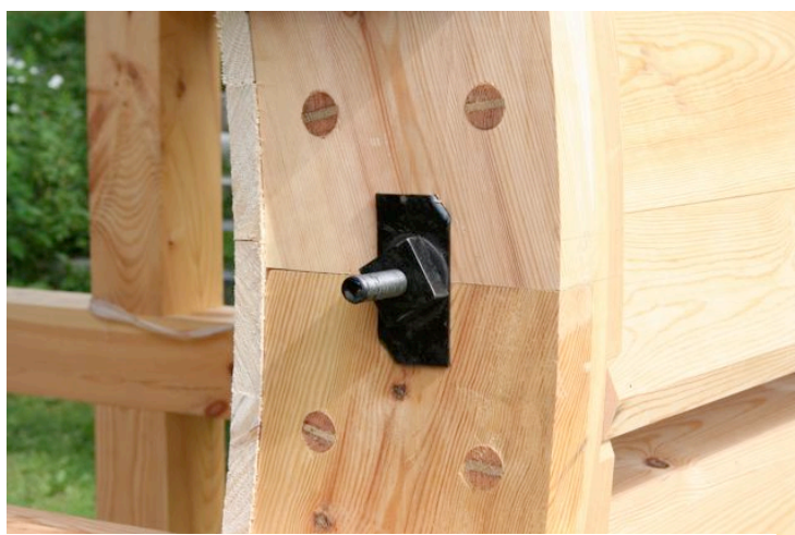
3. Detalj innfesting stålstang mellom sidestykker.
