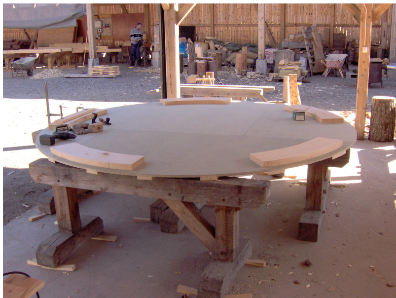
1. I hver ring var 5 løter ferdigkappet, som bildet viser.
