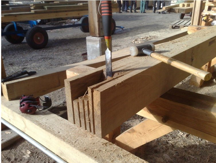
Figur 16 Mellanstolpe sågad med motorsåg
