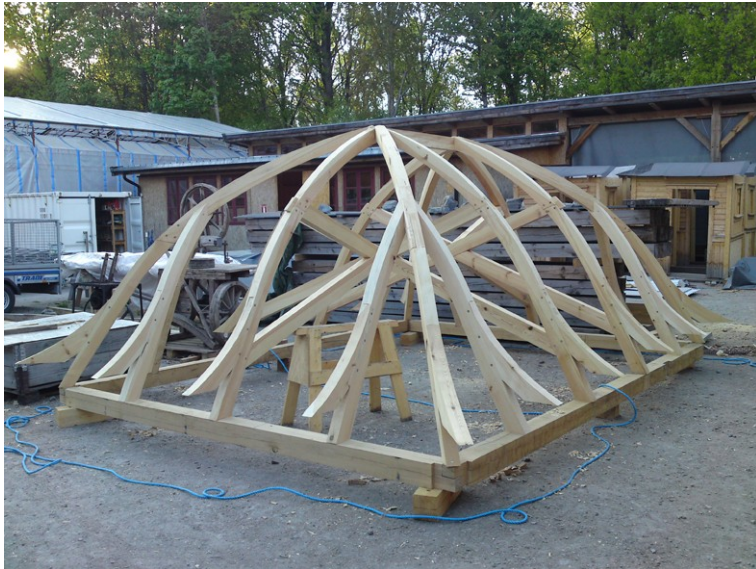
Figur 38 Den nästan färdiga takkonstruktionen
