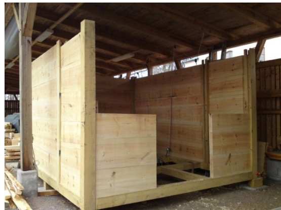
Figur 24 Hål för fönster tas upp i efterhand
