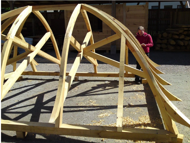
Figur 39 Hyvling av gradsparrens utsida
