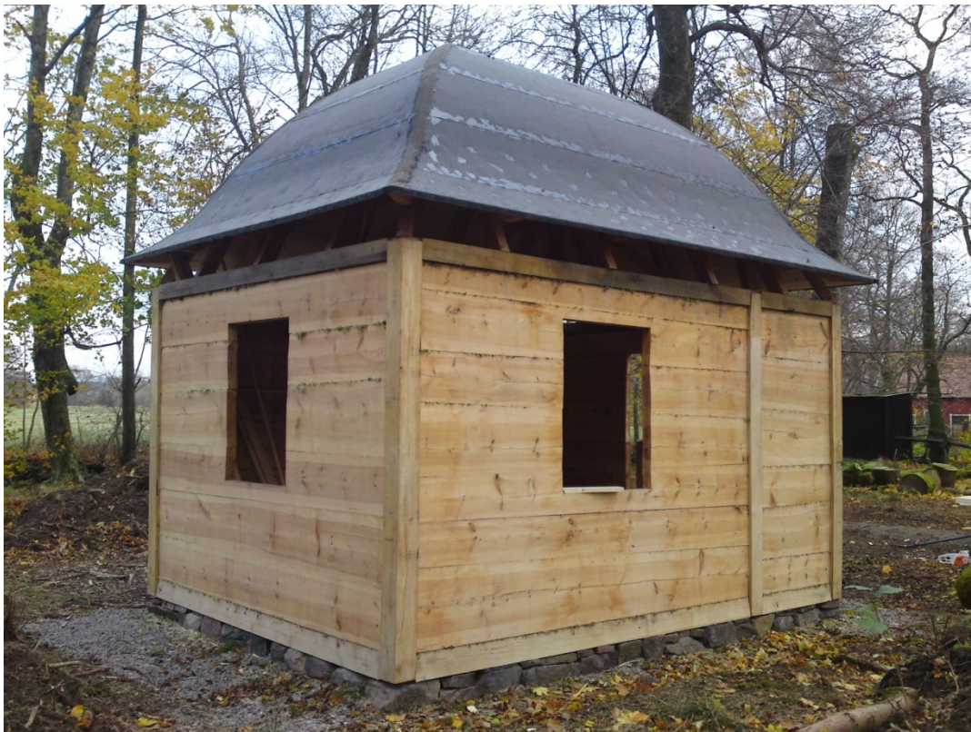
Figur 47 Fönster, dörrar listverk och koppertak monteras vid senare tillfälle.
