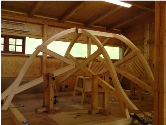
Figur 31 Provmontering av takstolar
