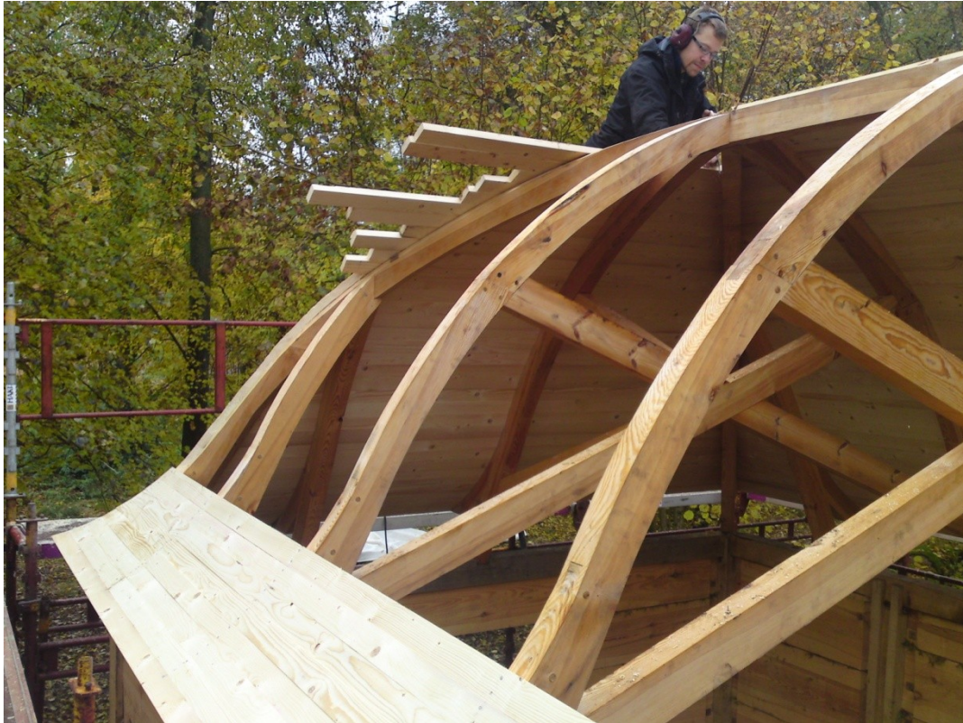
Figur 46 Glespanel 28x70 som underlagstak
