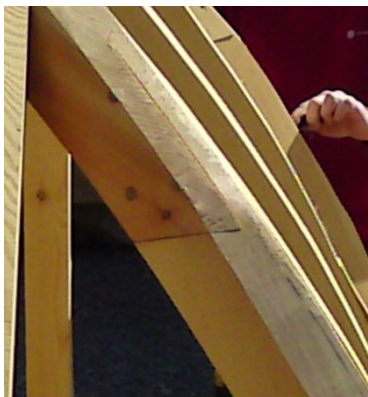
Figur 35 Skarv på gradsparre
