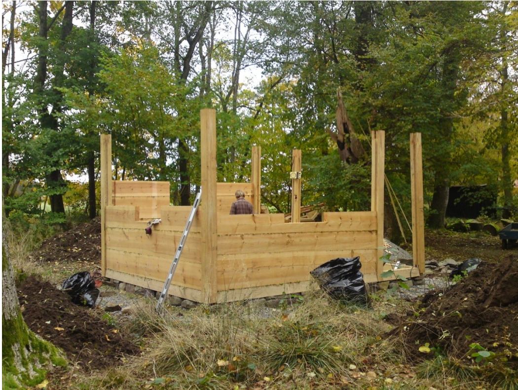
Figur 44 Skiftena har nu torkat så mycket att de går att lyfta i för hand
