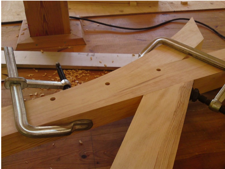
Figur 29 Möte mellan sax och löstass
