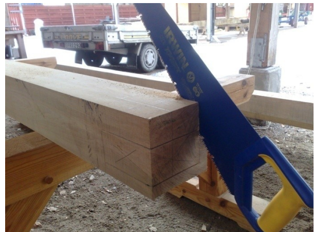
Figur 14 Utsågning av stolpens tapp
