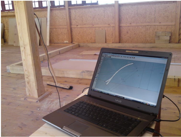
Figur 26 Uttagning av mått för takstolar
