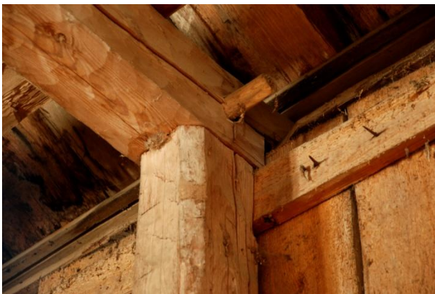
Figur 8. Tapp och tapphål med dymling. Foto av författaren
