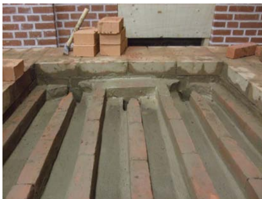
Figur 42. Kanalväggarna på valvet.
