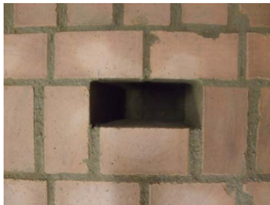
Figur 33. Rökanal i det huggna förbandet.
