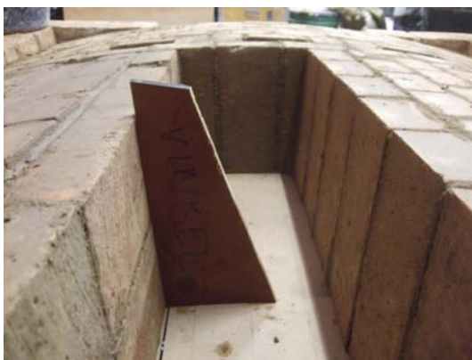
Figur 34. Vinkelmall så att stenarna riktas in mit sin gemensamma brännpunkt.
