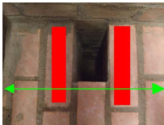
Figur 35. Trekvartarna som skapar rökkanalen ligger i förband med en intakt del av valvet.
