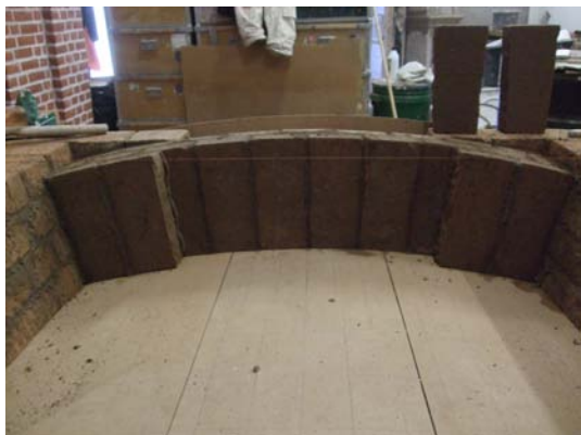
Figur 30. Murning av hugget förband.
