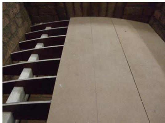
Figur 29. Valvformen som markeras med nödvändiga hjälplinjer.
