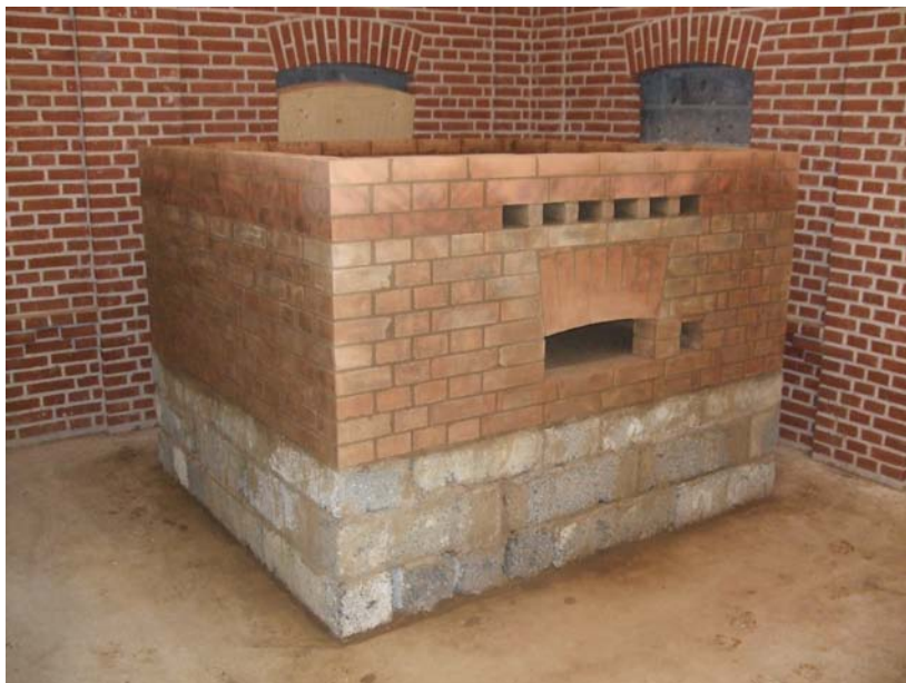
Figur 44. Färdigmurad bakugn efter de förutsättningar och avgränsningar som getts i inledningskapitlet, ritningar se bilaga 2.
