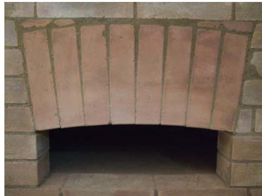
Figur 27. Valvbåge med mycket tunna fogar.
