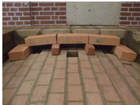
Figur 41. Alternativa rökkanaler över valvet.
