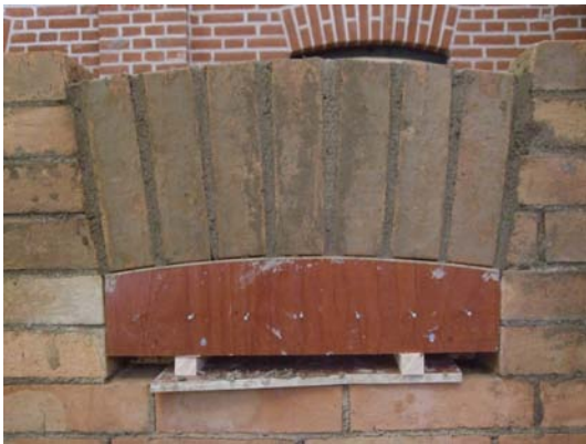
Figur 26. Valvbåge med för tjocka fogar.
