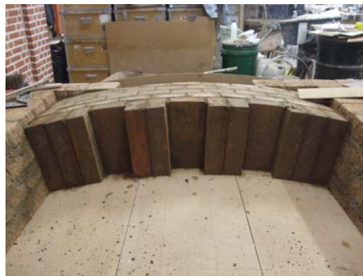
Figur 31. Murning av rökanaler i hugget förband.
