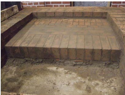
Figur 16. Del av ärilen. Sten murad på högkant och på kant.
