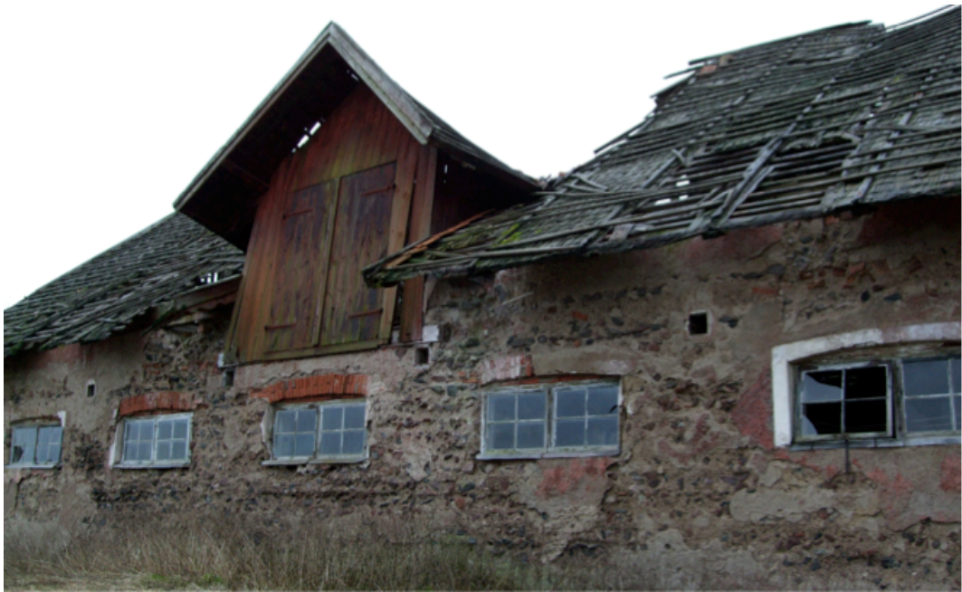
fig. 1, Stallet i Österäng. Del av fasaden mot norr med den delvis raserade lastkupan. Lastkupans underkant ligger i nivå med bjälklaget och ytterväggen reser sig ytterligare 50 cm ovanför bjälklaget. Lastkupan bryter därför igenom takfoten och är samtidigt så bred att kupan inte rymms mellan två takstolar utan "skär igenom" två mellanliggande takstolar. Det är denna typ av lastkuper med sina särskilda byggnadstekniska problem som studeras i detta arbete. Takfallen var ursprungligen täckta med en trelags spåntäckning och har senare fått ett tvåkupigt tegeltak ovanpå det. De hål som syns i bjälklagshöjd är ventilationen av stallet, något som uppmärksammades tillsammans med andra hygien- och rationalitetskrav under 1800-talets senare hälft. I ett stall avsett för 18 hästar bör det ha varit viktigt med en väl fungerande ventilation. Foto: Johannes Törnqvist
