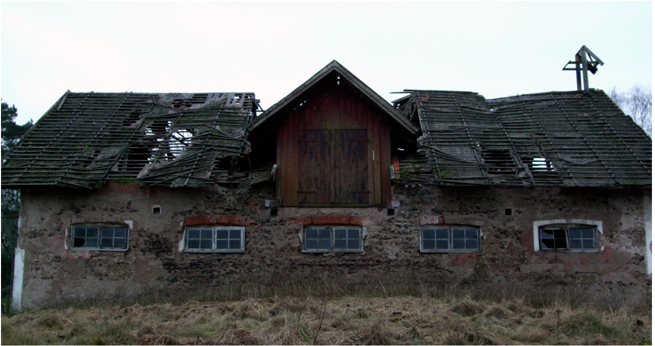
Fig. 5 Norra fasaden av stallet i Österäng
