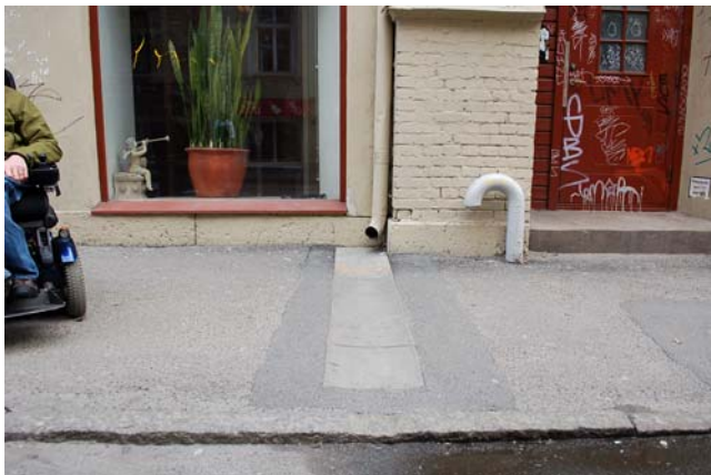
Ill. 34. På norra sidan är rännalarna mycket bra utformade. Denna sida är också asfalterad, vilket underlättar användandet av gatan.
