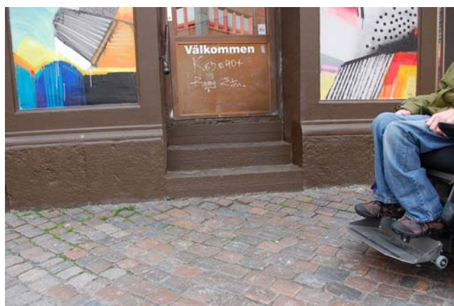
Ill. 35 och 36. Högt placerade entréer kräver ramp eller lift. Nordhemsgatan 22 - Andra Långgatan 10
