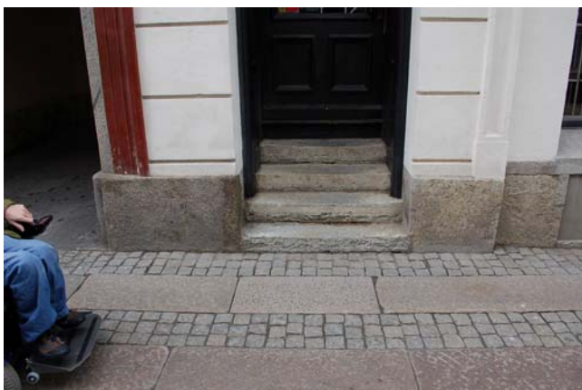
Ill. 17. Höga trappor kan enkelt åtgärdas med handtag på varje sida. Trappstegen kan kontrastmarkeras. Vallgatan 21
