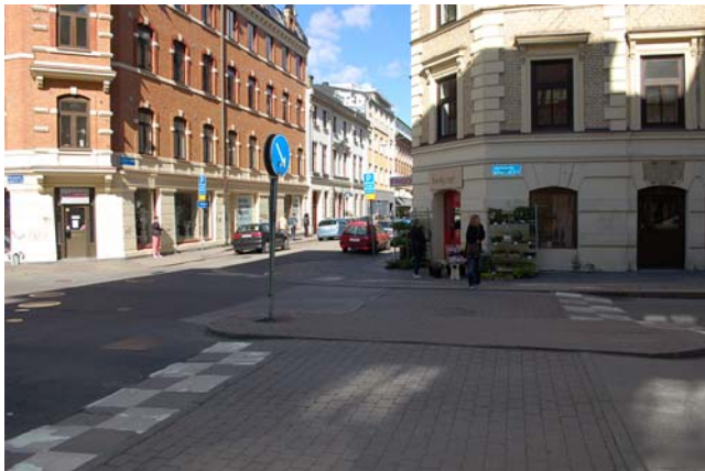
Ill. 33. Övergångsstället Andra Långgatan - Värmlandsgatan saknar kontrastmarkeringar för synskadade.
