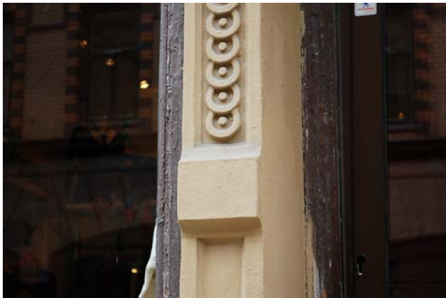
Ill. 27. Detaljer som omfattningar och profilerade lister (D) finns i många av entrépartierna. Andra Långgatan 13
