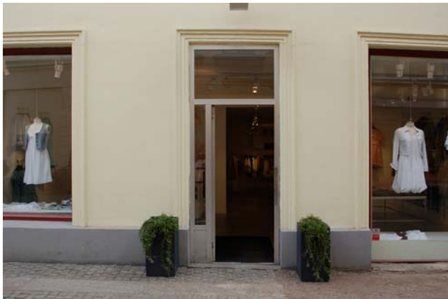
Ill. 8. Många av sockelväningarna är väl bevarade (A), i denna entré finns även en profilerad dörromfattning som samspelar med fönsteromfattningarna (D). Vallgatan 28
