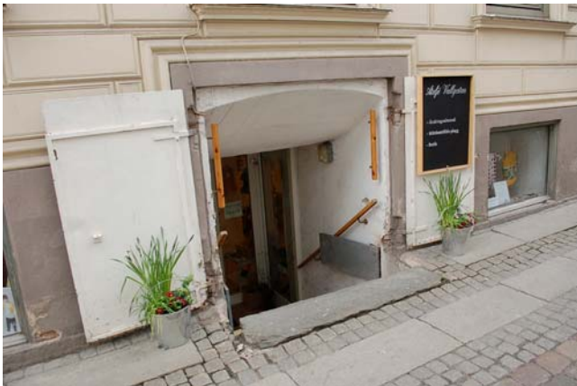
Ill. 20. En brant trappa till källarlokal – inte ett enkelt anbjälpt binder. Vallgatan 11
