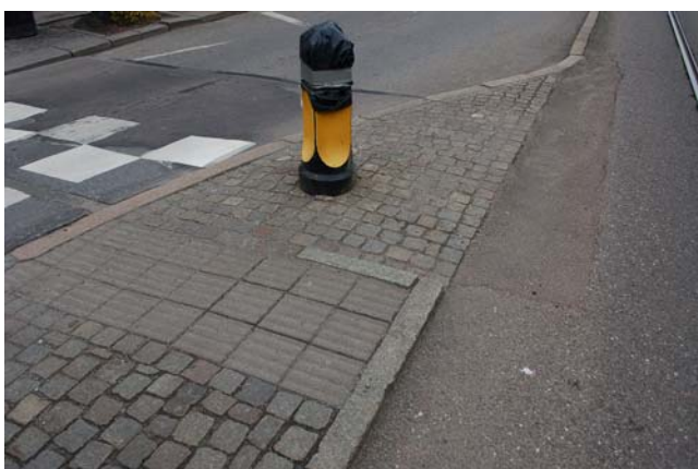
Ill. 13. Samma övergångsställe har ledstråk för synskadade, vilket kan vara svårt att uppfatta pga. den ojämna gatstenen.
