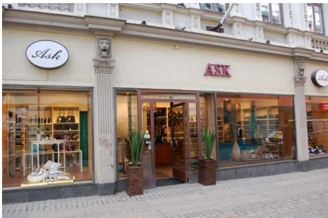
Ill. 10. Vallgatan 27. Här är sockelväningen också omgestaltad, dock med större varsambet mot det övriga fasaduttrycket än i exemplet ovan. Ursprungliga detaljer finns kvar i form av pilastrar krönta av lejonmaskaroner.
