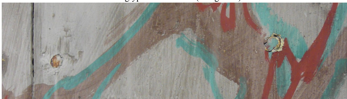
Figur 26. Spikar som håller de schablonbemålade panelen på plats i rum 204.
