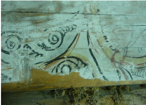
Figur 41. Fuktsskador, bortfall och frilagd grundering.
