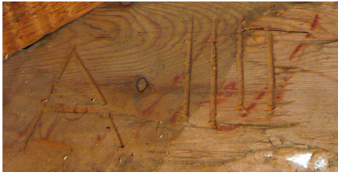
Figur 29. Flyttmärken, A markerar röste och IIII markerar röstets fjärde stock.
