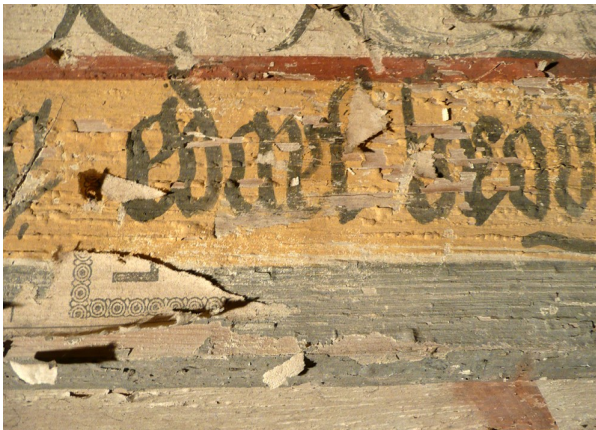
Figur 43. Pappersrester, flagning och färgresningar.
