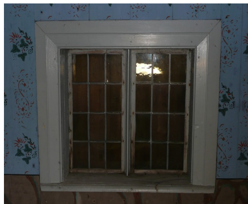
Figur 13. Fönster på östra väggen, rum 104.
