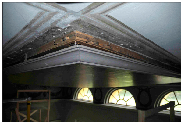
Fig. 20. Finspångsplafondens montering. Foto: Jessika Envall
