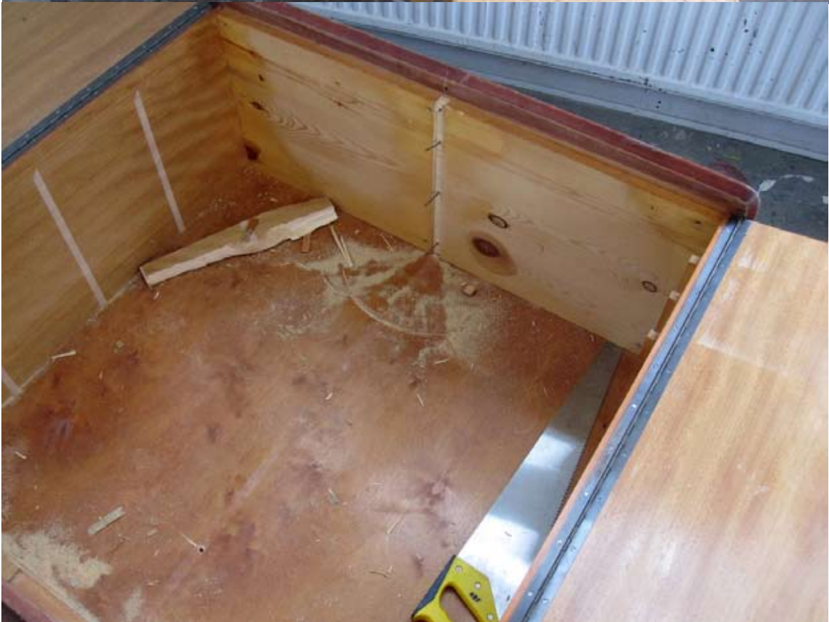
Bilder från borttagningen av mittväggen.
