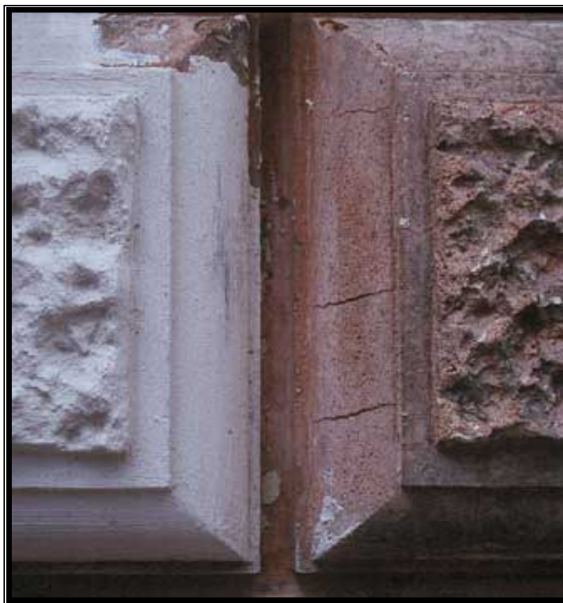
Rusticering i naturlig cement. Före och efter borttagning av färg. 7
