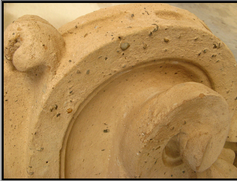
Ornament i naturlig cement från en kyrka i Wien, skadat av erosion. Materialets ballast har blottats. Färgen på cementet är av den ljusare, centraleuropeiska varianten.
