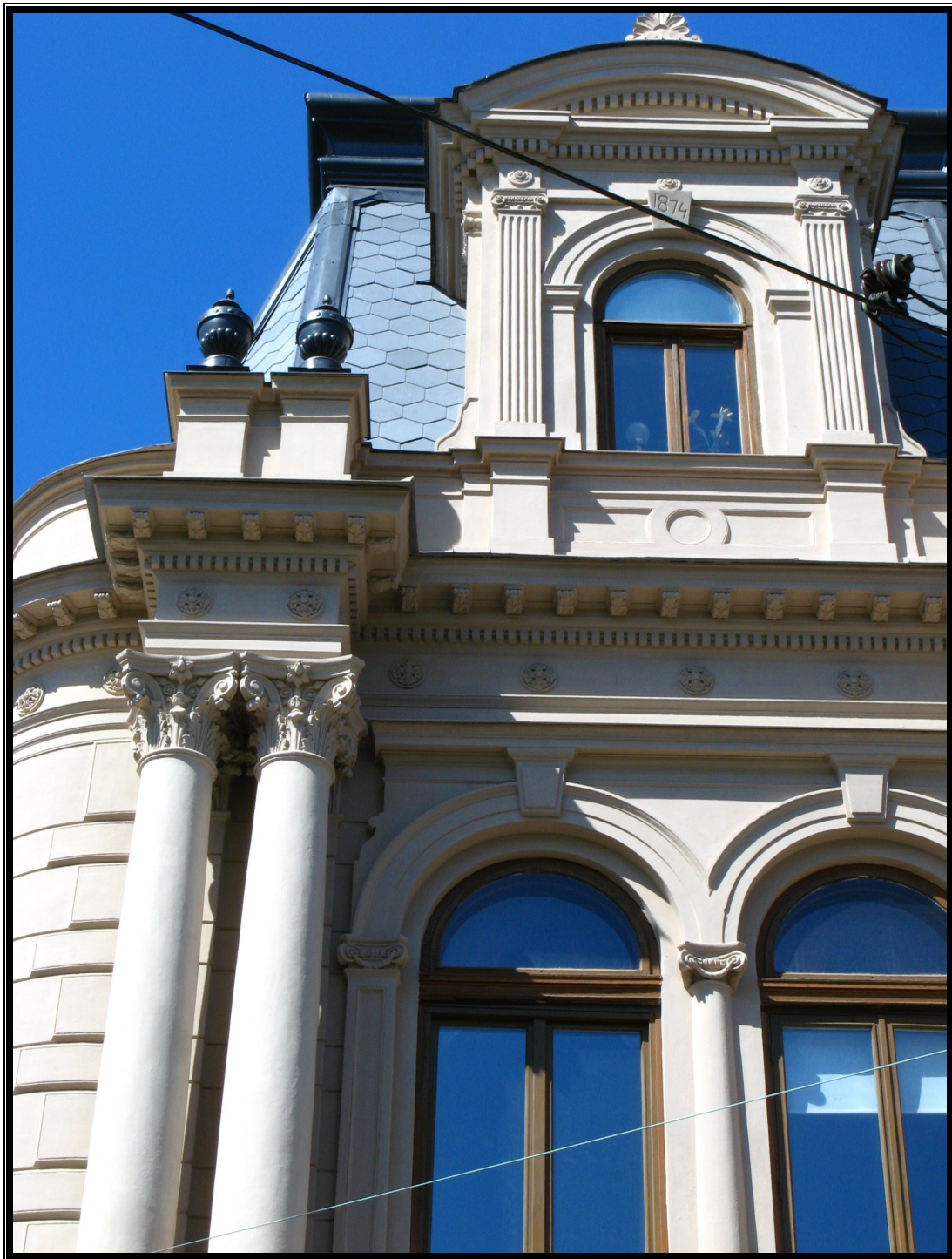
Detalj från Heymanska villan i Göteborg. Uppförd i naturlig cement 1874. Restaurerad 2005-2009
