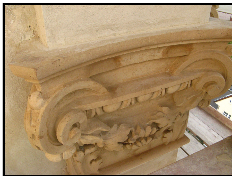
Detalj från nyrestaurerat kapital i naturlig cement. Wien.
