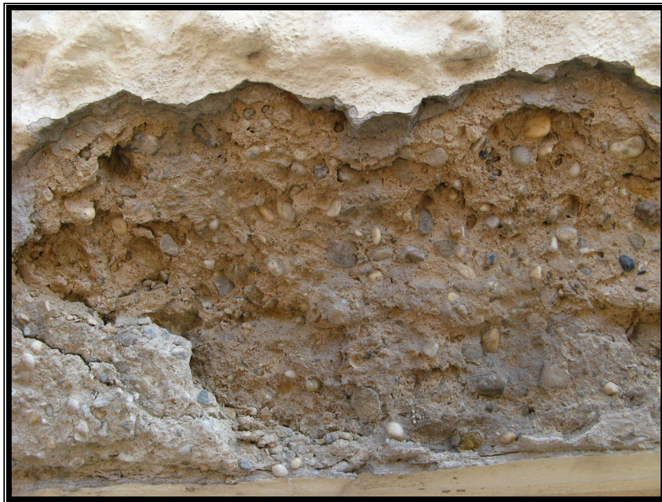
Större grus har använts som ballast till naturcementbruket i denna rusticering på en byggnad i Wien.
