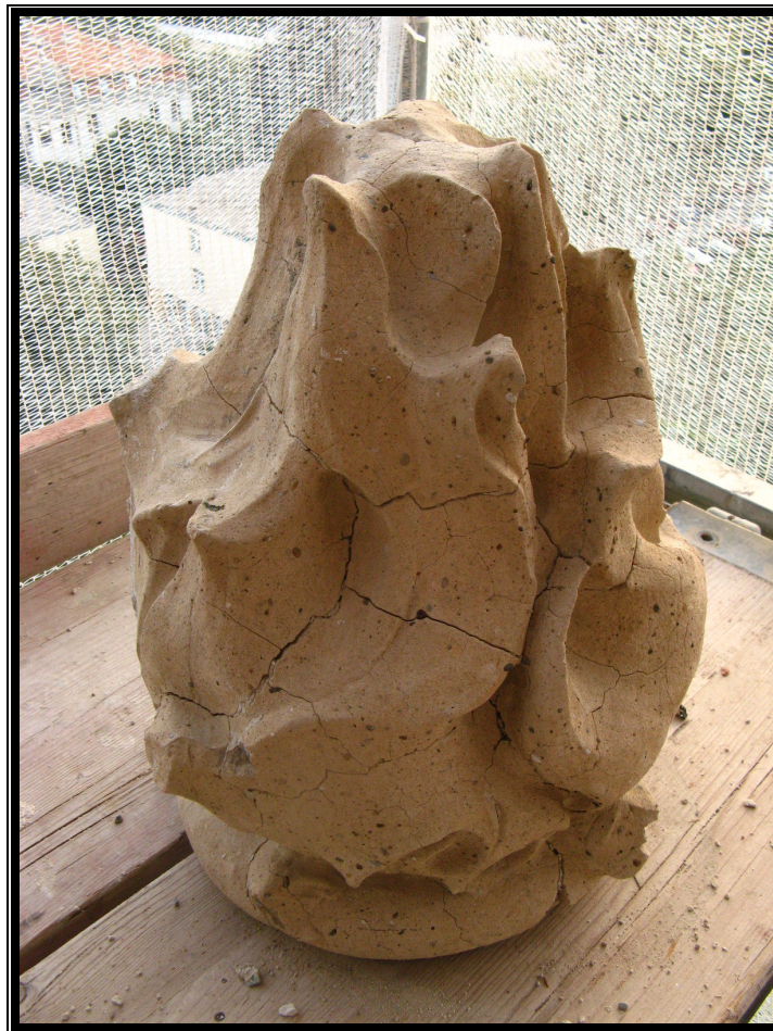
Eldsflamma i naturlig cement, nedmonterad och färdig för restaurering med cement-slurry. Wien.
