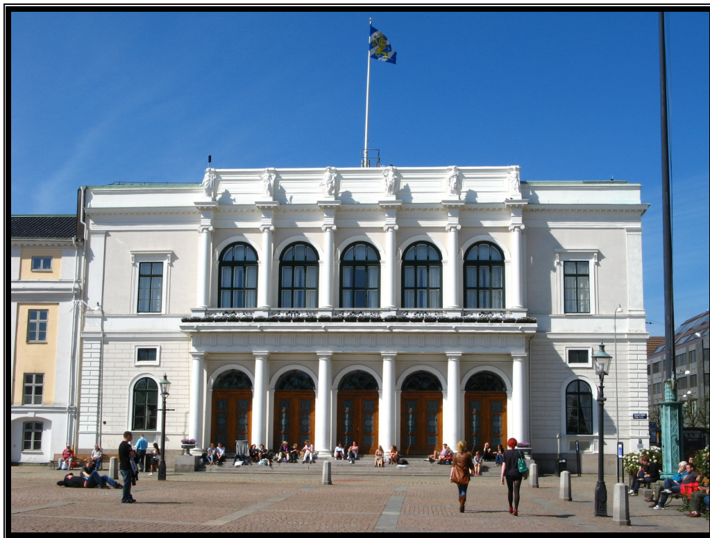
Börshuset uppfördes 1844-49 med fasadputs i naturlig cement. Hur ska det restaureras?
