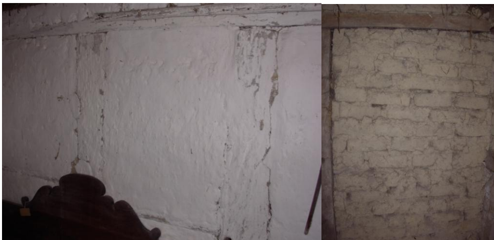
Ill. 19: Innervägg av lersten sedd inifrån drängkammaren. Väggen är vitlimmad med kalk.
