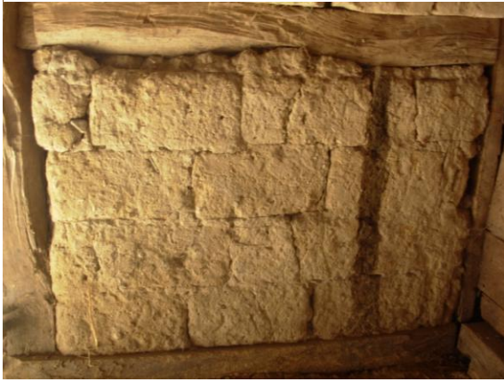
Ill. 14,15. Ovan: Lersten murade på kant innanför en linad vägg. T.h: Lager av lersten och kalksten ovanför samma vägg.
