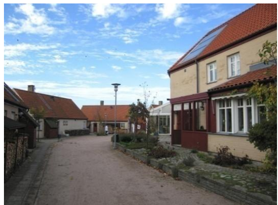
Figur 62. Genomsläppligt markmaterial och solpaneler på taken, ger minskad miljöpåverkan. Toarps ekoby, Malmö. Foto: Jorchr, Wikimedia commons
