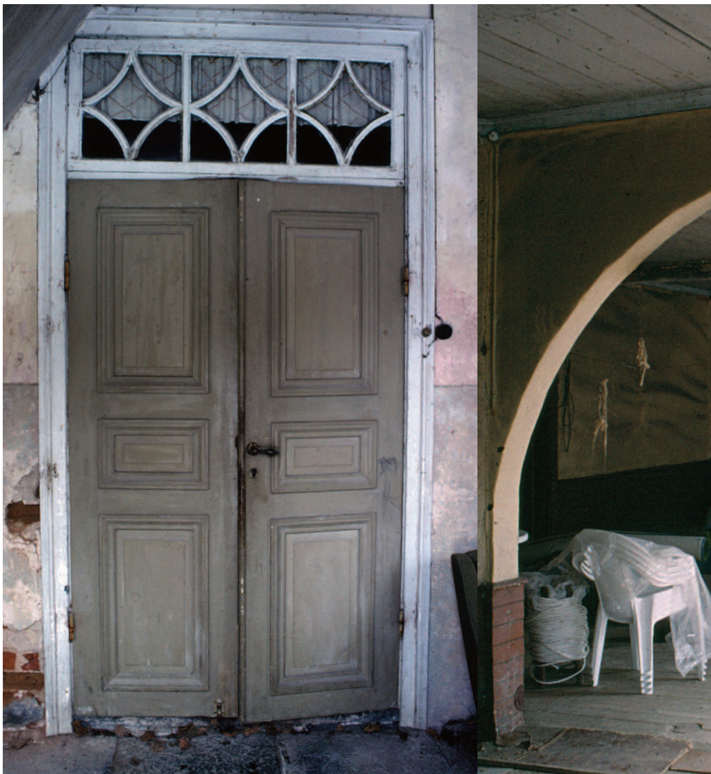
31. Dörrarna leder från förstugan till tingsalen i Kinne härads tingshus vid Enebacken i Holmestad. I vänstra hörnet skymtar vindstrappan, som ofta låg så nära salsdörrarna att inte ens dörrfoder fick plats. Vi ser också en glimt av golvet, som består av kalkstensplattor. Det var trångt i förstugan, men materialen var påkostade och slitstarka. Foto Olinska stiftelsen.
