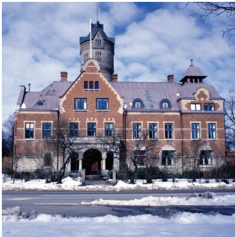
73. 1904 invigdes Kinnefjärdings, Kinne och Kållands häraders nya tingshus i Lidköping, Västergötland, som hade ritats av boråsarkitekten Lars Kellman. Exteriören präglas av kontrasten mellan den råa tegelytan och den rustika behandlingen av naturstenen i bottenvåningen och entrépartiet. Den asymmetriska uppbyggnaden var inte unik i tingshussammanhang men det var vanligare att entrén lades i mittaxeln. I denna byggnad tycks dock arkitekten ha velat bryta med klassicismen och hämta inspiration från annat håll. Foto Olinska stiftelsen.
