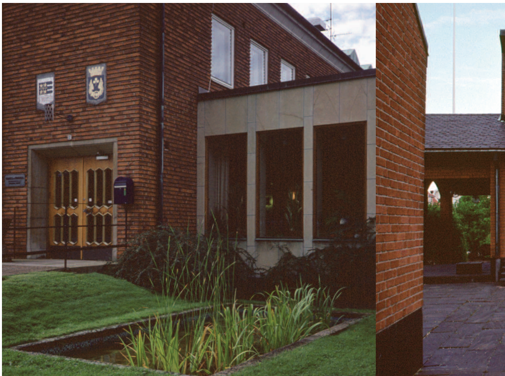
117. Eslöv är ett av få tingshus där delar av den ursprungliga trädgårdsanläggningen fortfarande finns kvar. Lägg också märke till den tidstypiska blandningen av tegel och natursten, och häradsvapnen ovanför entrén. Foto Olinska stiftelsen.
