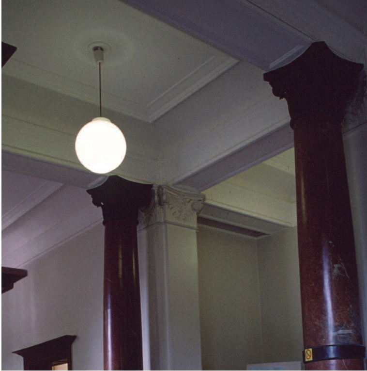
78. Entréhallens tak har givits en kraftfull utformning och förefaller bäras upp av kolonnerna, som flankerar ingången till tingsalen. Foto Olinska stiftelsen .
