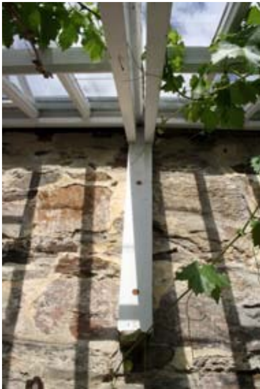
Ill. 32. Trärege ovan vilar i sin tur på en träklack som är inmurad
