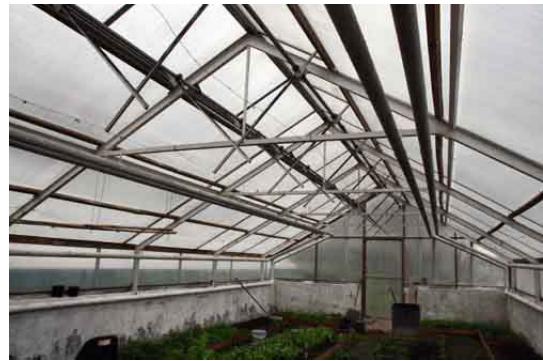
Ill. 19. Det äldre växthuset. Takstolskonstruktion.
