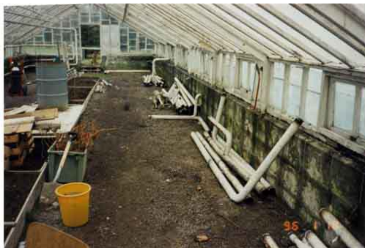
Ill. 2. Det större växthuset, som det såg ut innan ombyggnationen från glas till plast. Här fanns också ventilationsluckor i väggen, som kan skimtas. Här plockas också värmerören ned. Bild tagen 1996.
