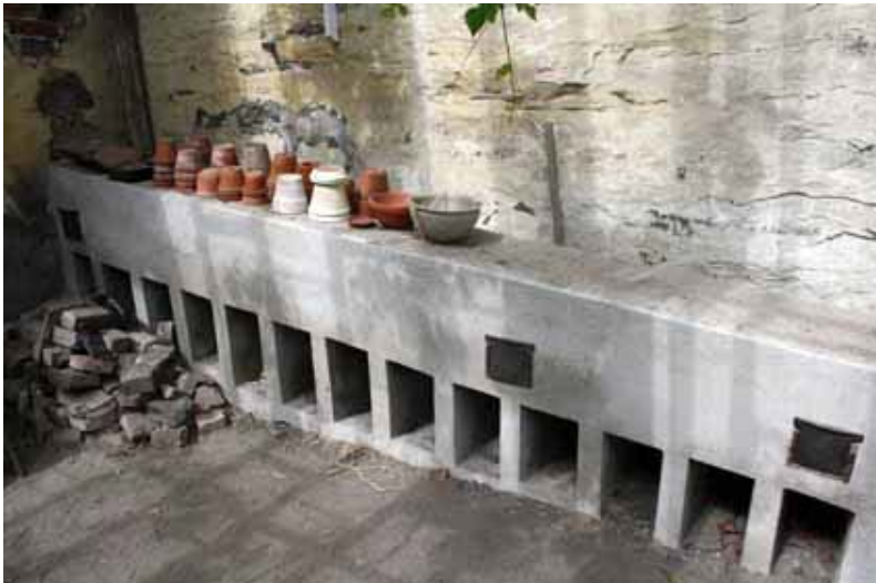
Ill. 30. Den restaurerade kanalen, med plats för bränsle i utrymmet under. Kanalen har en lätt lutning, för att rök och värme lättare ska färdas igenom den och vidare ut till skorstenen bakom väggen till vänster.
