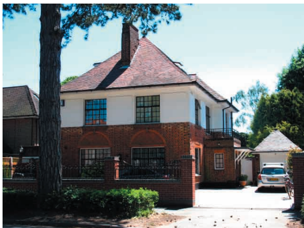
Figur 1. Det tillhörande huset ligger norr om trädgården. Sett från gatan norr om huset.
