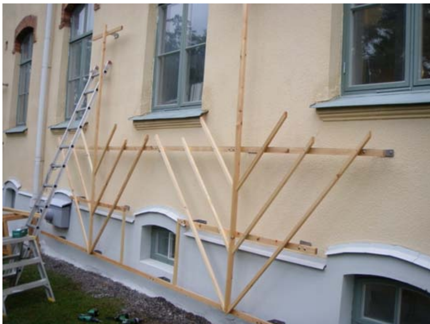
Fig.75. En del av 30x30 mm ribborna har kommit på plats i palmettspaljéerna.
