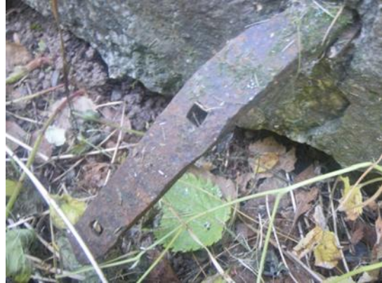
Fig.20. Ett av de tre handsmidda fästena som finns kvar i stenmuren.
