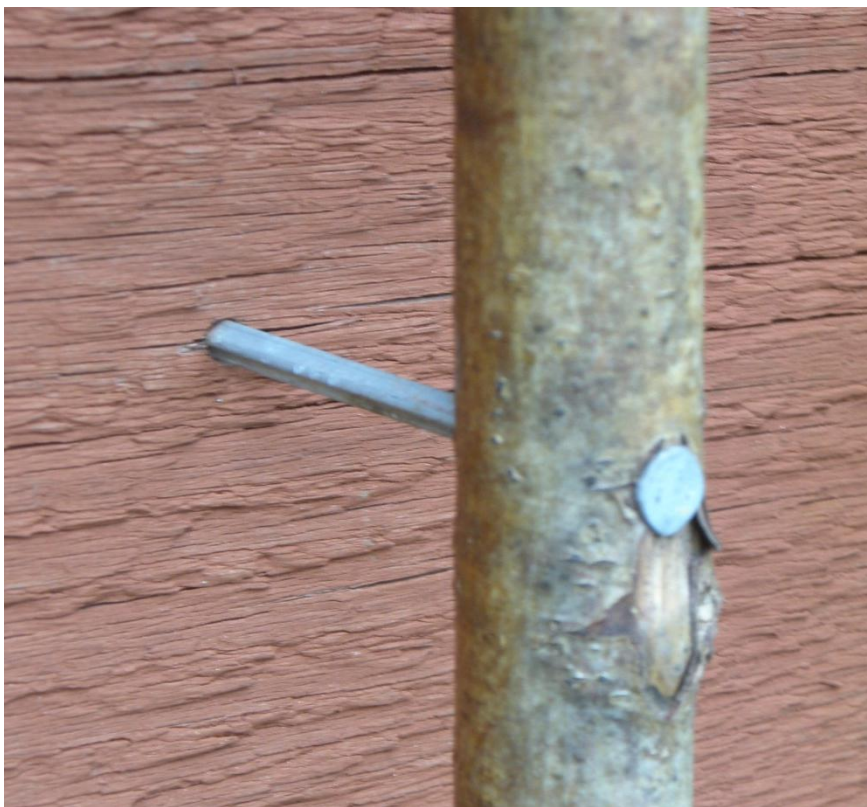
Fig.55. Spaljé stödet är gjort av hasselstörar, fastspikade i planket.
