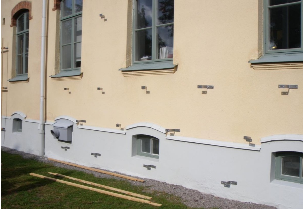
Fig.99. Bilden visar en del av fasaden med gråmålad sockel, ventilationstrumma och källarfönster. Ovanpå ligger en "midja" (dropplista i plåt.)
