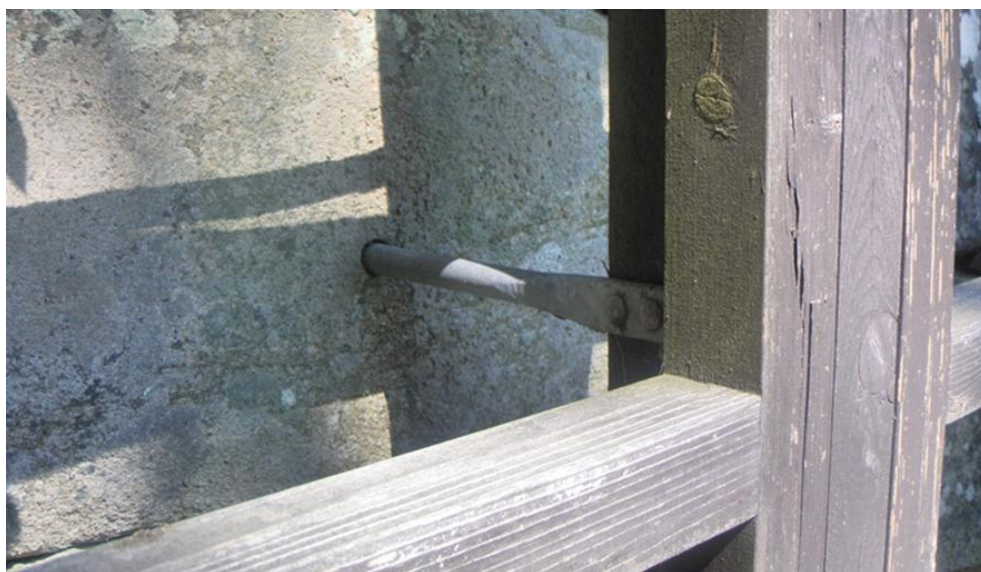
Fig.38. Fästet i muren.
