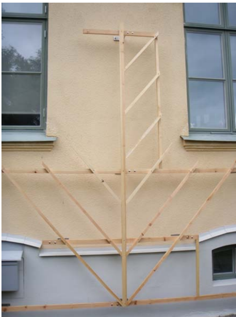
Fig.76. En av palmettspaljéerna är nästan färdig.
