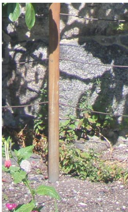
Fig.27. Fundamentet består av ett nedgrävt järnrör. Kanske att det finns något längre ner i backen.
