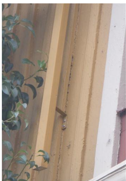
Fig.34 och 35. Bilderna visar ställningen och fästet i väggen.
