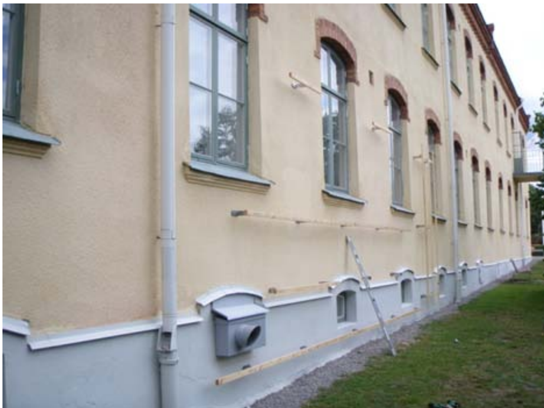
Fig.73. De två palmettspaljéerna under tillverkning. Nu har nästan alla vågräta ribbor kommit på plats.
