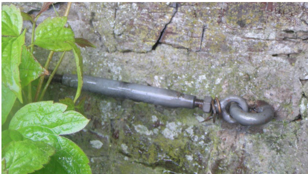
Fig.49. Fästet i muren
