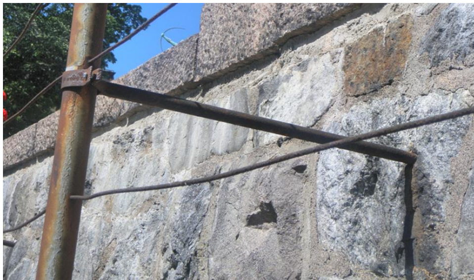
Fig.26. Fästet i muren.
