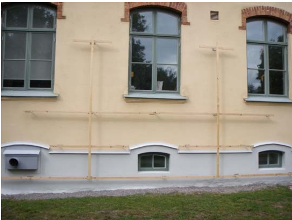
Fig.74. Själva grundstommen är klar i palmettspaljéerna. Med grundstommen menar jag de kraftigare ribborna som mäter 50x30 mm bredd. På dessa kommer de smalare ribborna att skruvas fast.
