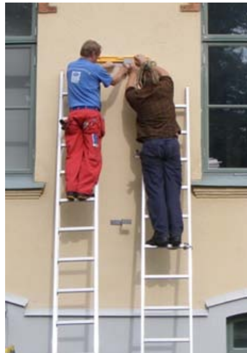
Fig.65 och 66. Lodet används för att få fästena att hamna rakt under varandra. Vattenpass för att få fästena i våg samt i lod.
