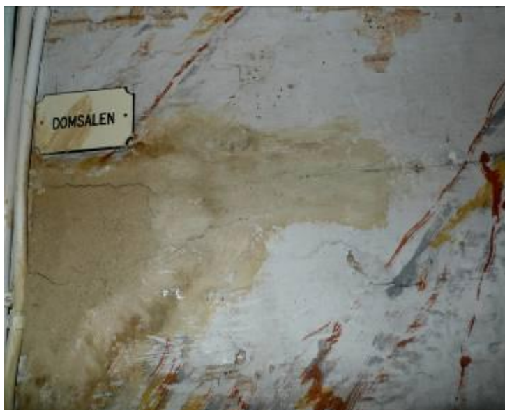
Figur 18. Vid eftervattningen penslades ett tunt lager lerklining ut på limfärgsmåleriet utanför lagningarna.
