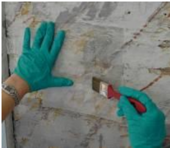
Figur 10. 1. Ytan förvättades med etanol, genom japanpapper.
