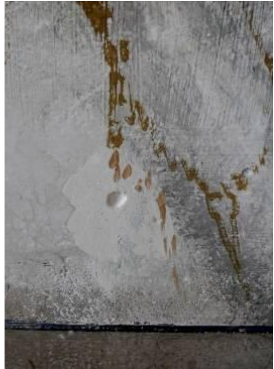
Figur 8. Vissa hål och bortfall har vid ett tidigare tillfälle målats över på ett mycket enkelt sätt och utan att först ha lagats.
