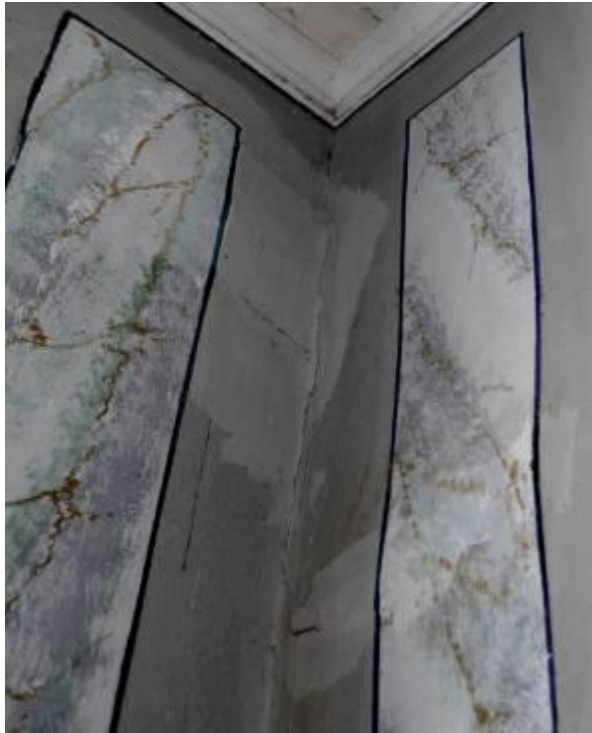
Figur 7. Vid ett tidigare tillfälle har ramlisten har på några ställen målats i på nytt, med en något ljusare färg än originalet.
