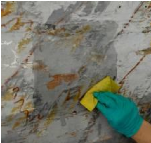
Figur 15. 3. Överskott sögs upp med en fuktad trasa.
