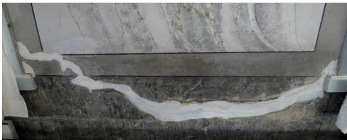
Figur 17. Lagningarna av putsbortfallen patinerades innan målning med en tunn mager oljefärg.
