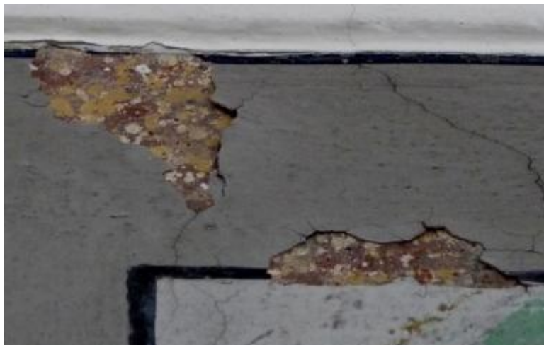
Figur 9. Längst upp eldstaden är det understa målningslagret synligt, en gul och vit stänkmålning på röd botten.
