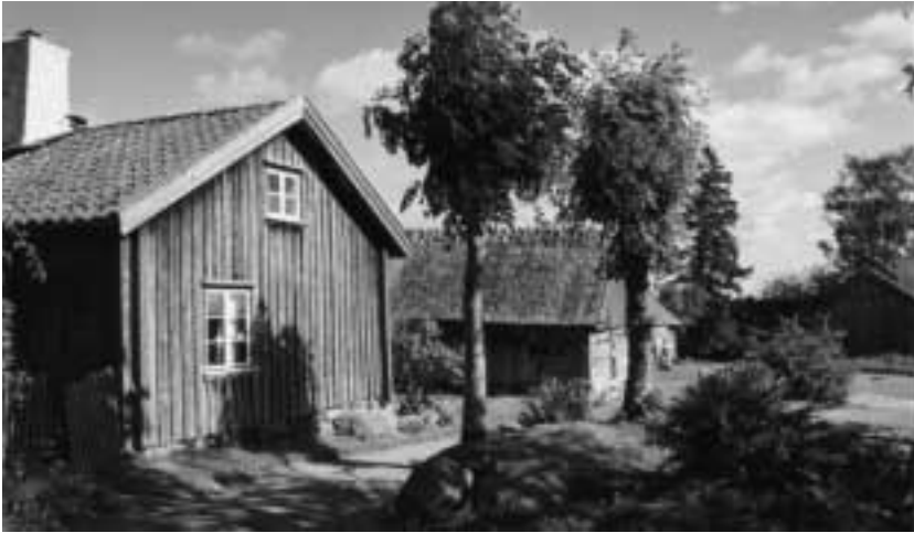
Bilden visar Äskhults by. Boningshuset till gården "Deras" närmast i bilden har såväl tegeltak som brädklädsel. Ekonomibygnaden bortanför boningshuset har halmtak samt ofodrade skiftesverksväggar. Foto: Per Hallén 2002.
