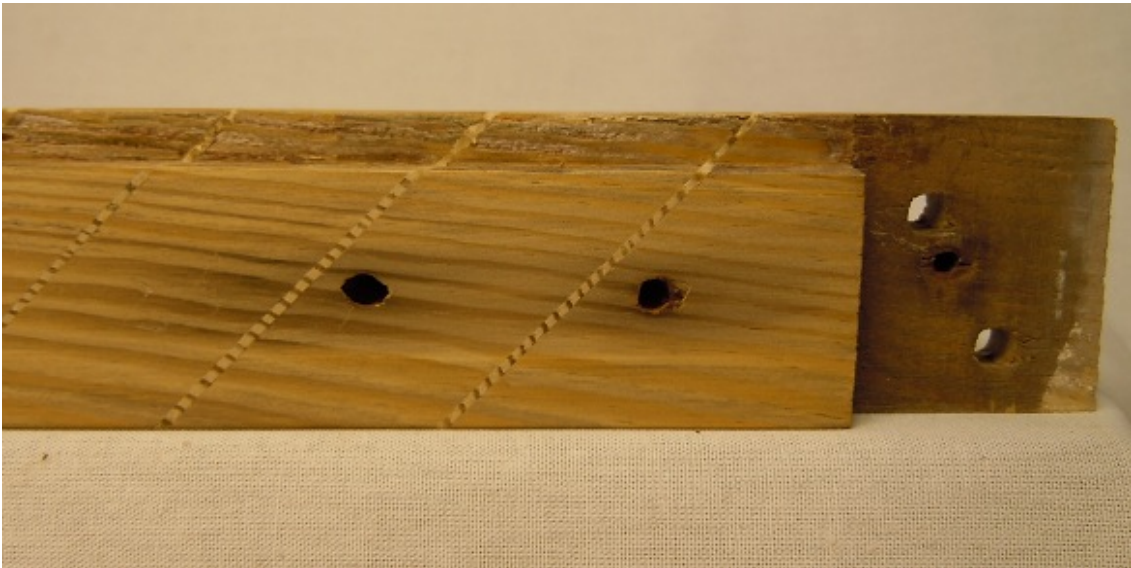
Figur 82 Färdig lagning där även gråträet är borthyvljat. Skruvhålen från beslagen är inte än pluggade.
