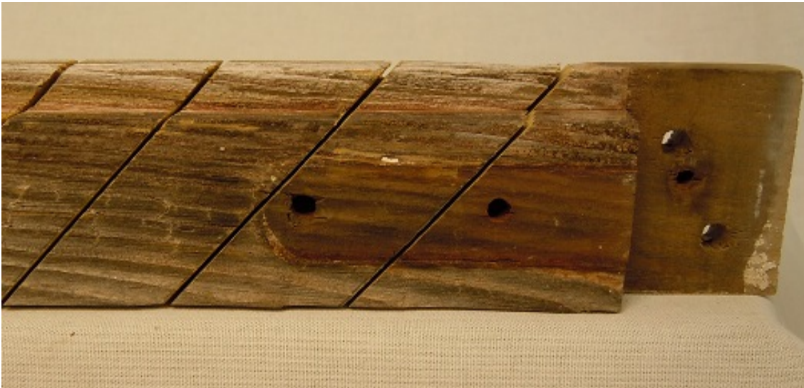
Figur 79 Sågsnitten i 45 graders vinkel in mot profilen.
