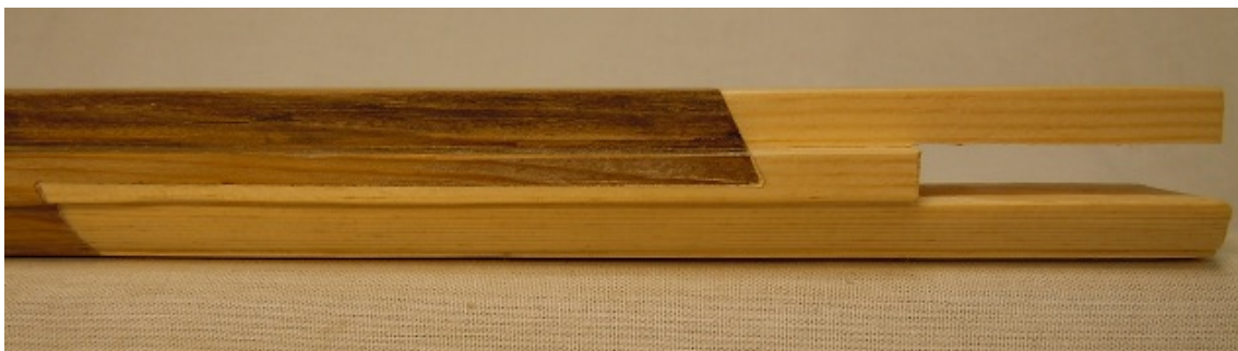
Figur 51 Färdig skarv på överdelen av ett sidostycke. Utsidans sågsnitt är geringssågat 30 grader för vattenavrinningen.
