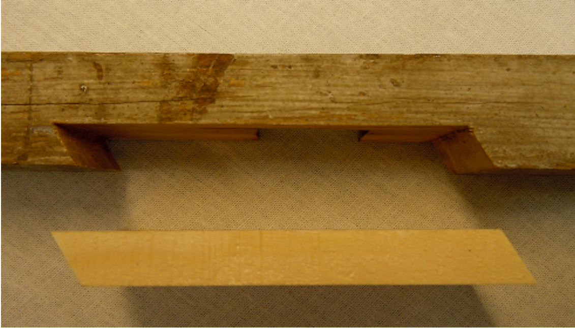
Figur 31 Ny träbit, ilusning, anpassas till urtaget.
