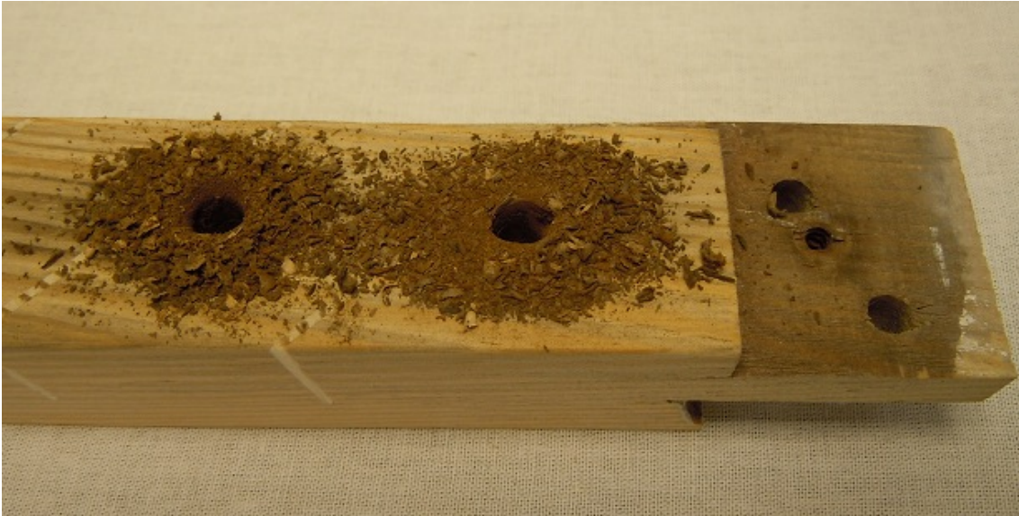
Figur 92 Avlägsna skadat trä och rost.
