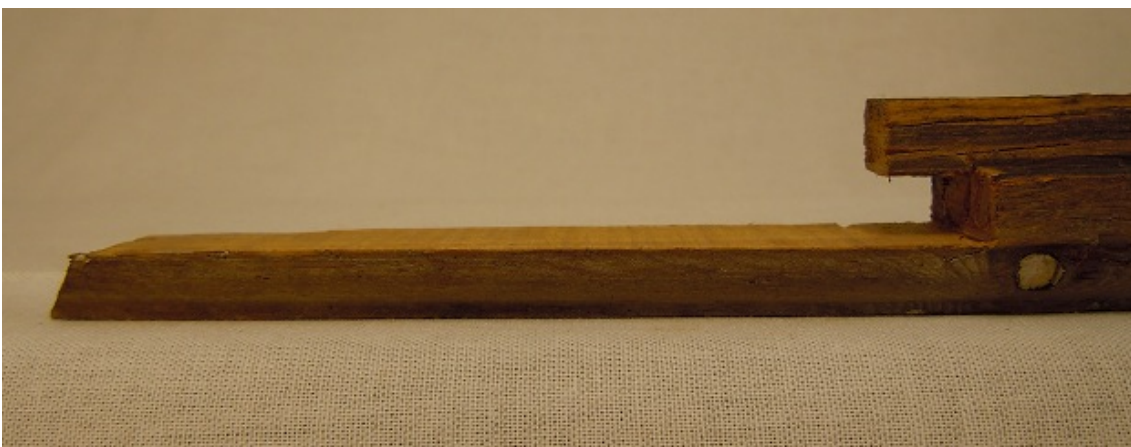
Figur 56 Skadan avlägsnad och profilen sparad. Falsryggen kapas något kortare så en klack, trappa skapas.
