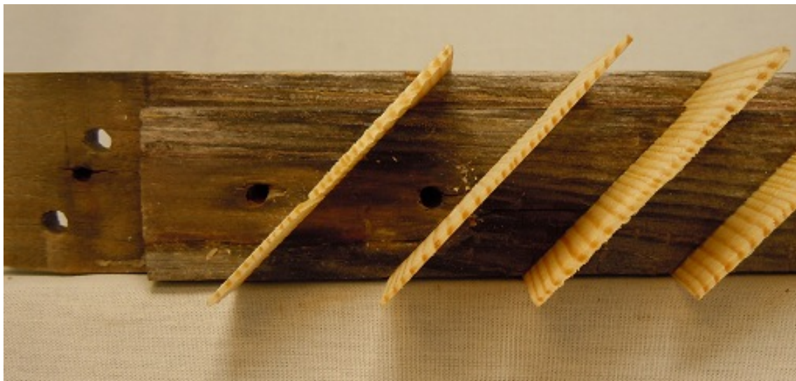
Figur 81 Limmade kilar inslagna i varje sågsnitt.
