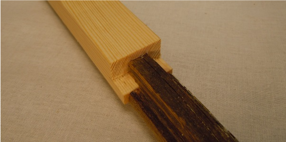
Figur 57 Nytt lagningsträ med övermått.
