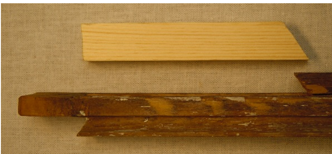
Figur 36 Ny lagningsbit tillverkas och passas in med något övermått på falsryggen.
