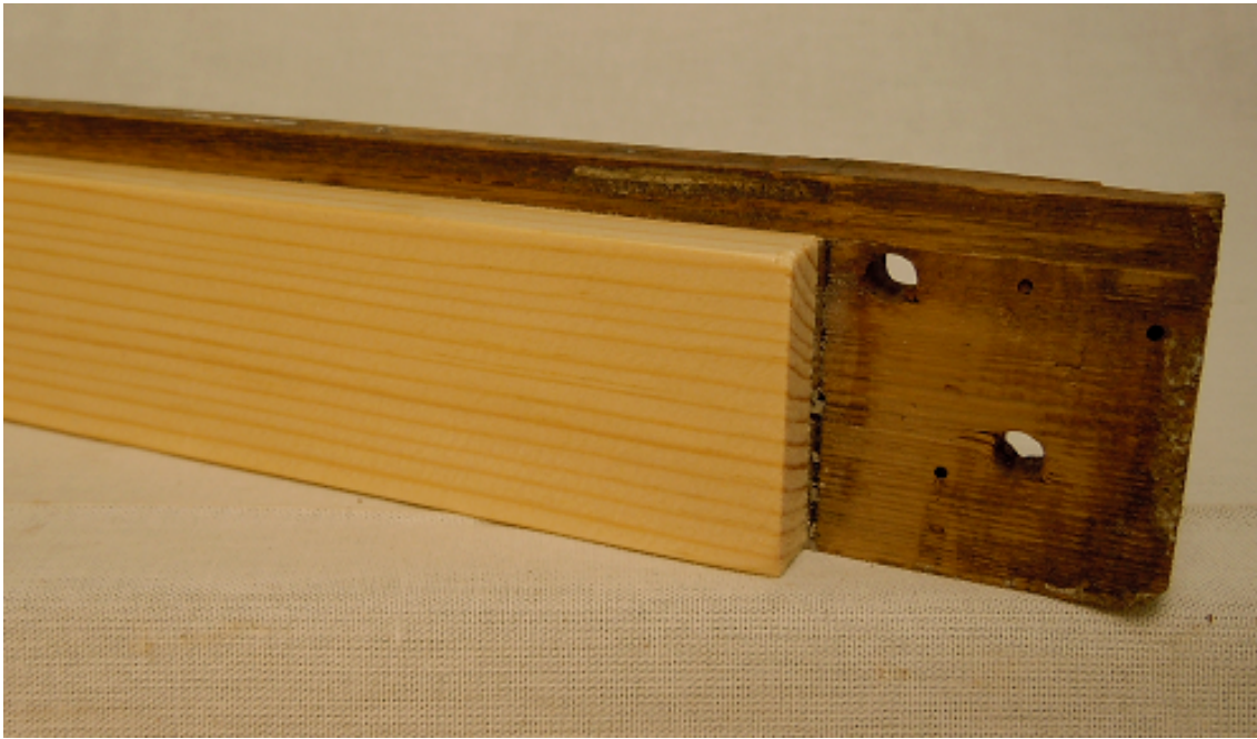
Figur 25 Halvsulning av utsidan på bågunderstycket in mot nacken.
