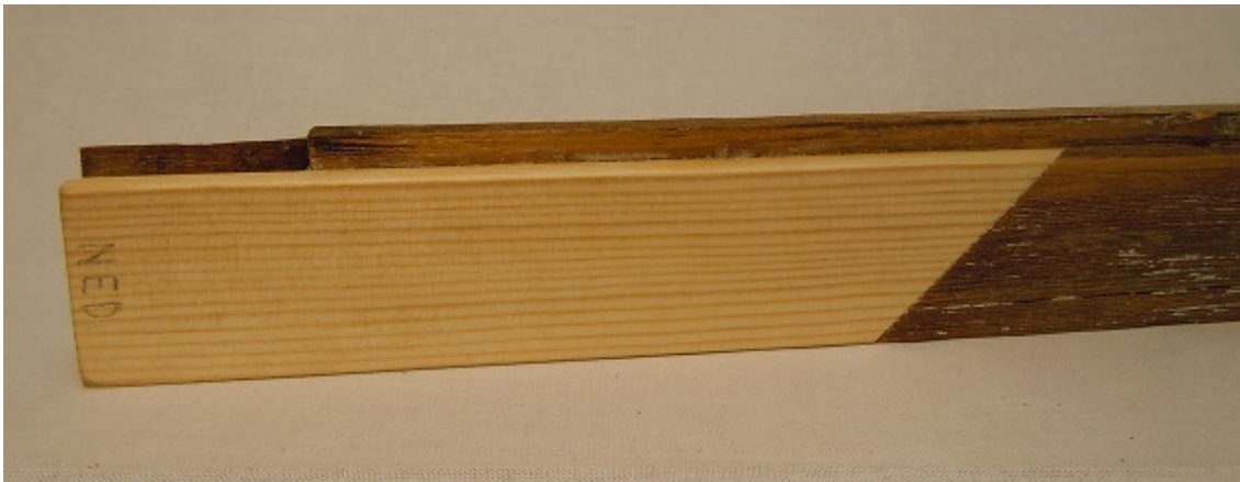
Figur 67 Justerad och färdig slitslagning/ halvsulning på bågsidostycket.
