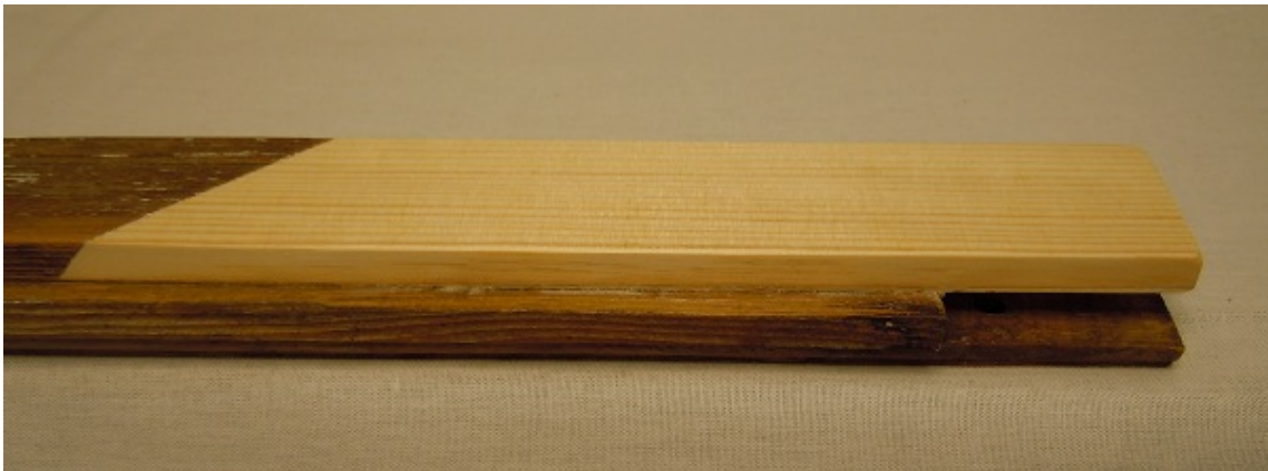
Figur 18 Lagningen är limmad och justerad enligt mall.
