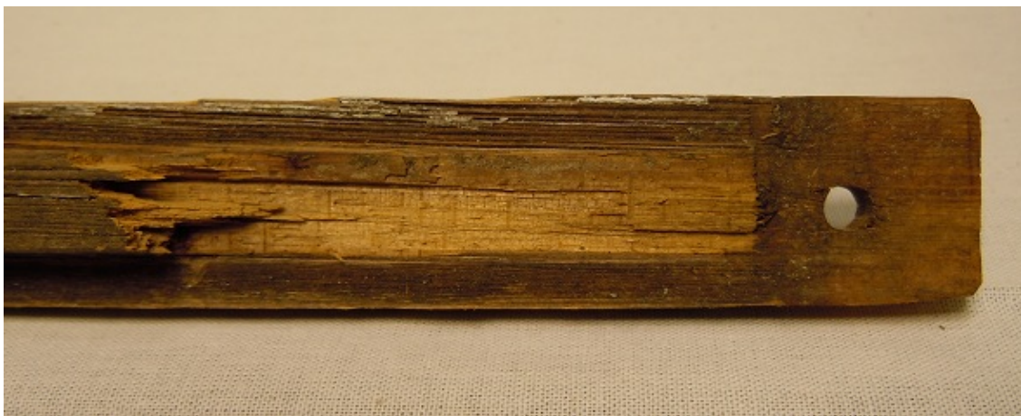
Figur 34 Skadad del av nacke och tappskuldran på en tvärgående spröjs.
