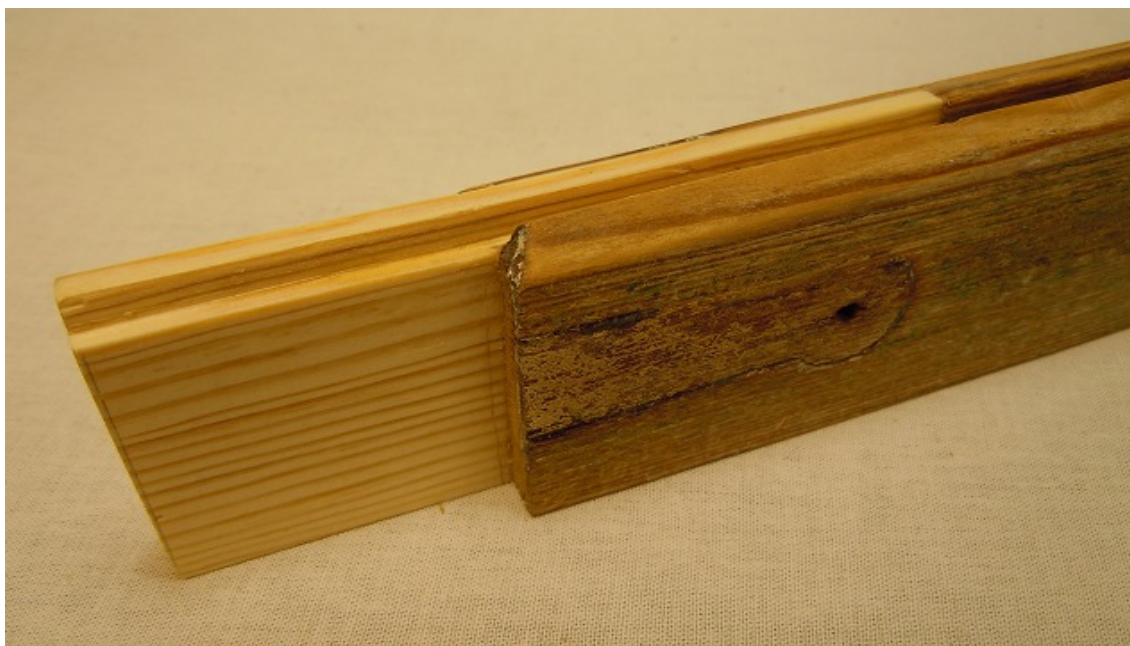
Figur 71 Färdig lagning med spårfalsen som löper ända ut genom tappen.
