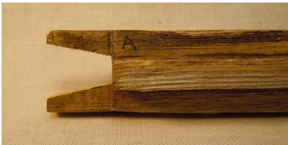
Figur 73 Skadeområdet bortsågat. Laxstjärtsformen kan med fördel vändas tvärtom.
