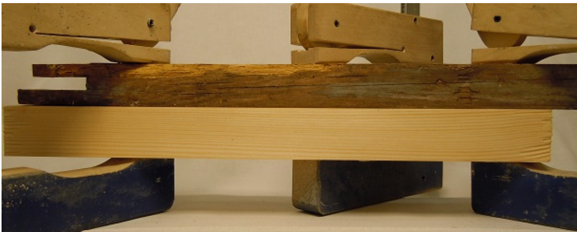
Figur 42 Lagningsbiten fixerad med några droppar vitlim eller montagelim. Tvingarna avlägsnas innan sågningen.
