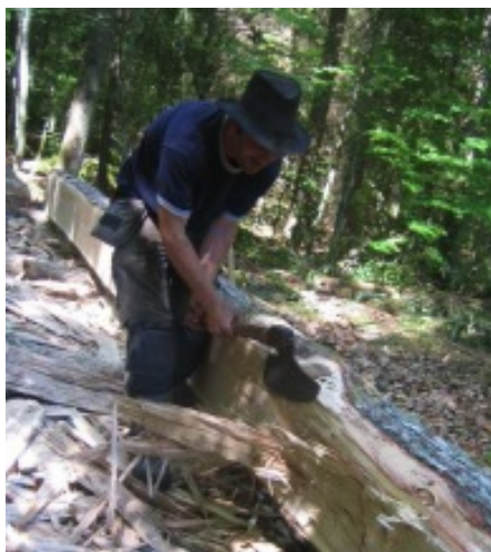
Timmerman Olof Andersson, under arbetet med att bila fram timret till Jordkällaren. Bilden visar tydligt den skånska typen av bilningsteknik; huggningen sker framåt och timmermannen står bredvid stocken. Foto tillhörande Olof Andersson.
