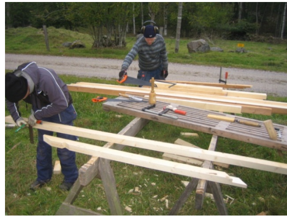
Tillverkning av takstolar till farstun
