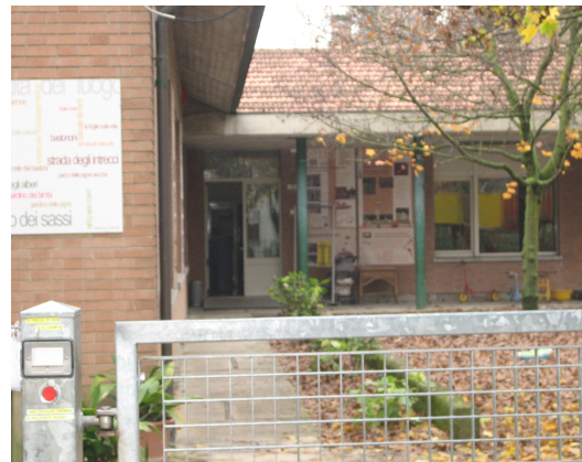
Grinden in till förskolan. På väggarna sitter dokumentations-tavlor.
