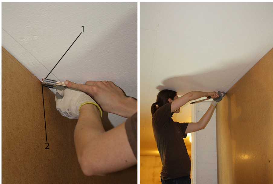
Fig. 70. Tumstock och penna är bra att "dra" skivkanten med. 1: Tumstocken följer takets eller väggens profil. 2: Pennan följer tumstocken och kopierar över takets eller väggens profil på skivan. Foto: Linda Andersson.
