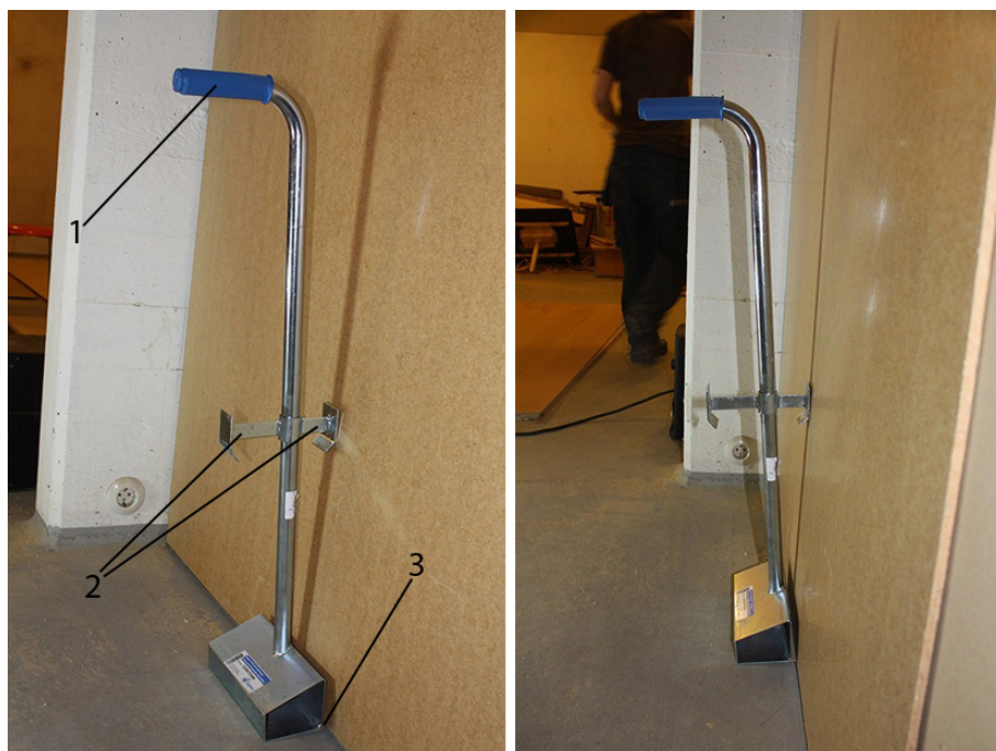
Fig. 74. På inrådan av Nils-Eric Anderson användes en skivhållare som är ett modernt hjälpmedel som utarbetats för att kunna montera skivor genom ensamarbete. Skivhållarens delar utgörs av 1: En stång med ett handtag. 2: En stav i två varierande längder. 3: En bottenplatta med en ca 1 cm bred list som skivan kan stå på. När skivan är monterad med skivhållaren kan den inte rasa utan det går bra att gå därifrån. Foto: Linda Andersson.
