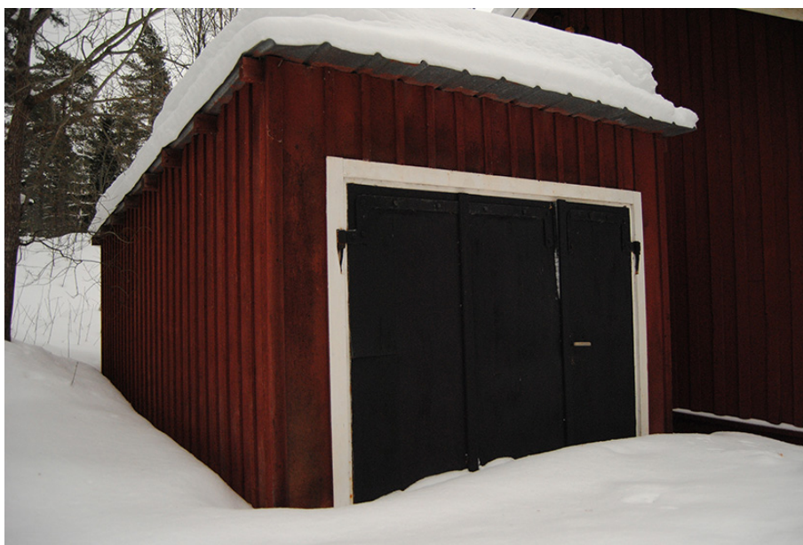
Fig. 31. Garage/ekonomibyggnad på Olofsfors bruk, målad med röd slamfärg. Slamfärg skyddar inte masoniten mot fukt.
