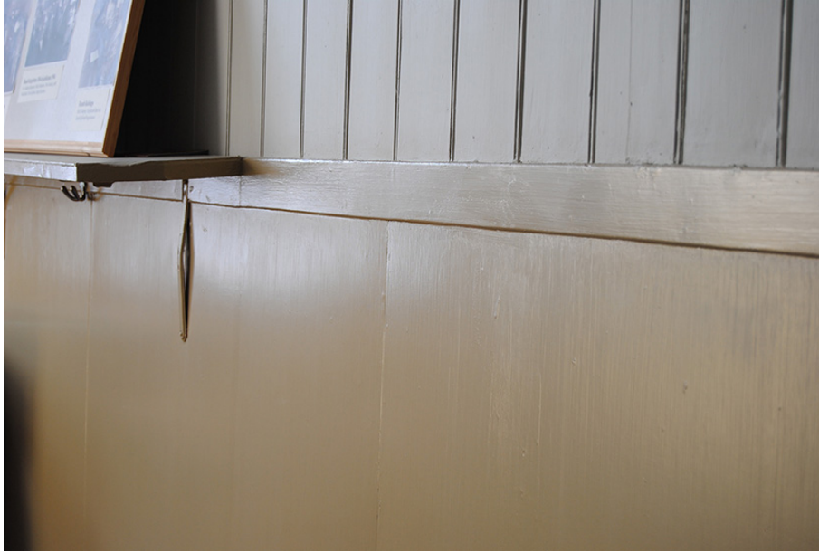
Fig. 26. Närbild av masonitboasering i Rundviks gamla skola. Skivorna är satta kant i kant utan fasningar. Masoniten har satts upp i barnens kapprum för att det tålde slitage och nötning.
