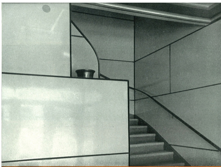
Fig. 10. Snygga, dekorativa lister som satts över skarvarna invändigt. Masonite lister (ingen sidnumrering).
