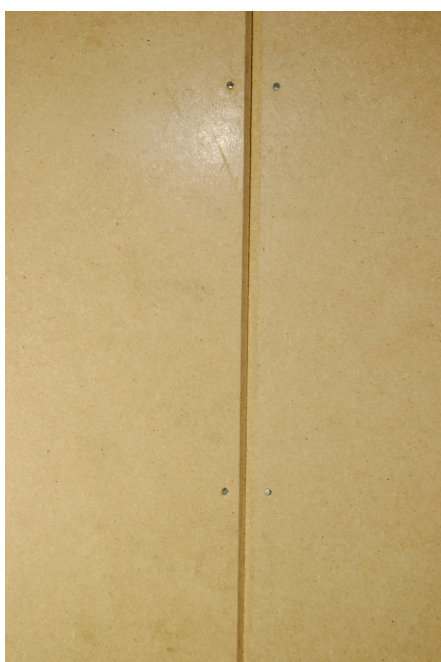
Fig. 79. De synliga/öppna fogarna gjordes med fashyveln GGC i torrt material. Kanterna hyvlades och skivorna sattes stumt kant i kant utan mellanrum. Den gick snabbt och lätt att utföra och resultatet blev snyggt. Då mycket av materialet var kvar efter hyvlingen var det lätt att föra samman skivorna utan att skada kanterna.
