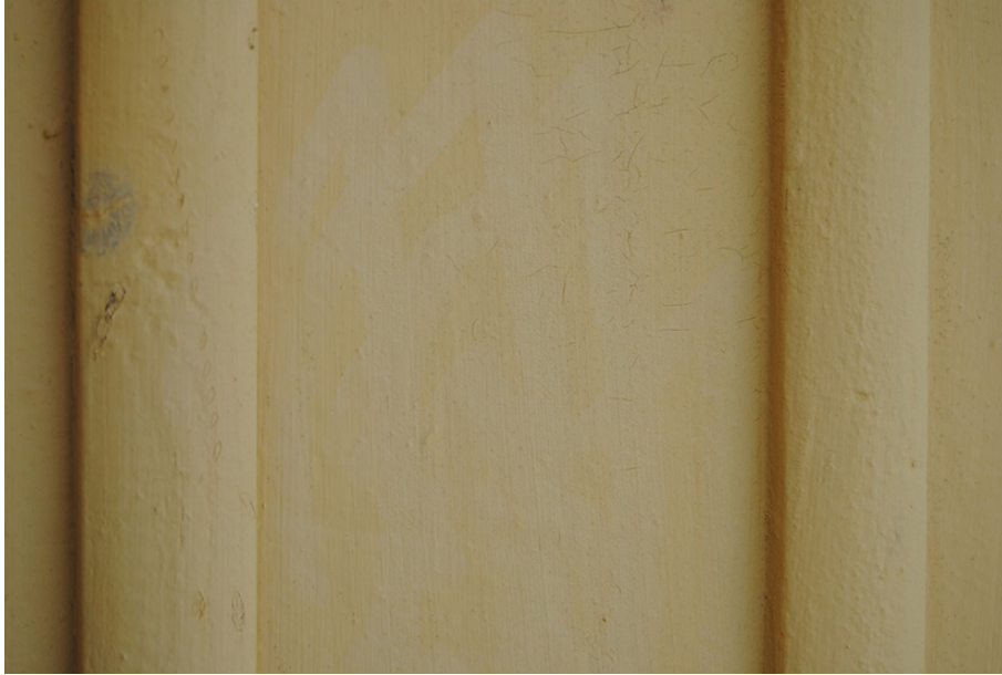
Fig. 36. Oskadd läkt på Rundviks skola. Fasaden är målad med linoljafärg som skyddad fasaden väl.
