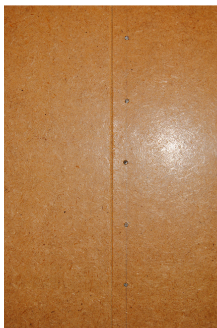
Fig. 80. De dolda omlottfogarna gjordes med fashyveln med pat. nr. 112 475 i blött material. Det var betydligt svårare att åstadkomma en snygg fog på detta sätt än i fig. 79. Då lite material (<1mm) var kvar efter hyvlingen var det svårt att föra samman skivorna utan att skada kanterna.
