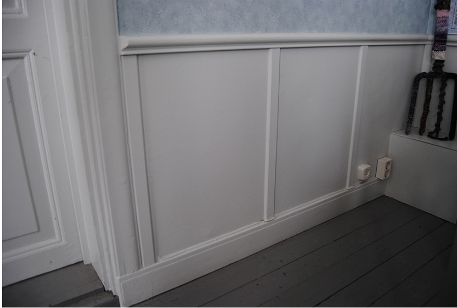
Fig. 24. Annan typ av boasering i samma byggnad som fig. 23. Här är listerna av massivt, profilhyvlat trä.
