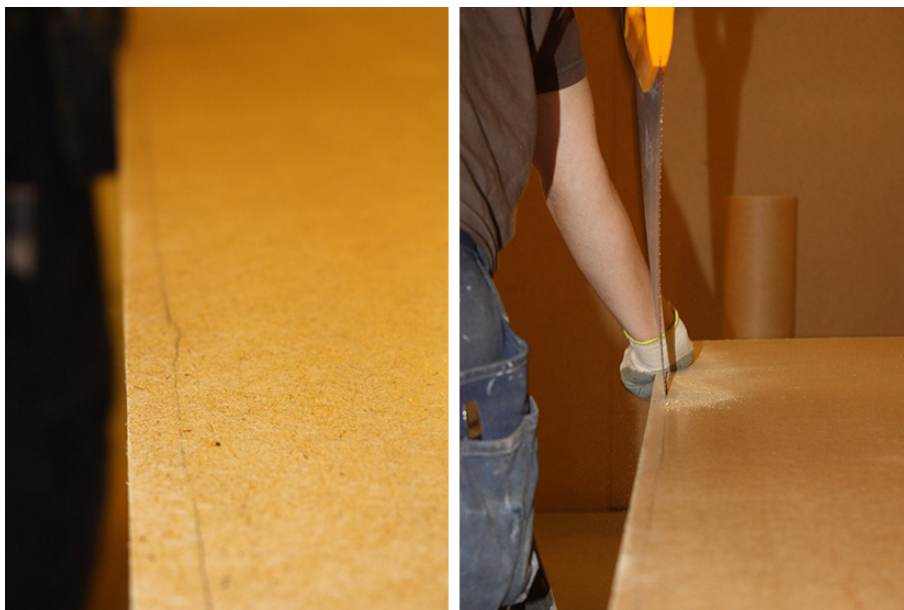
Fig. 66. Linjer som är vågiga, t.ex. sedan skivan dragits mot vägg, är lättast att följa med fogsvans. Det fungerar också bäst eftersom du kan utgå från den synliga sidan då urslaget blir på undersidan, se fig. 64. Foto: Linda Andersson.
