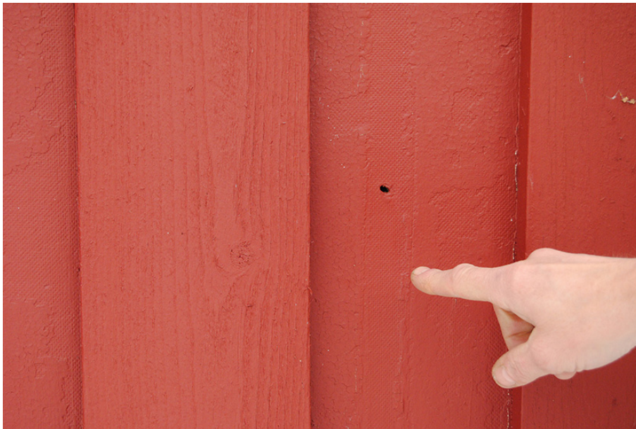
Fig. 35. På bilden syns ett märke efter den lockläkt som satt på huset när Lennart Olofsson köpte det. När huset renoverades med lockpanel utanpå skivorna täcktes inte alltid dessa märken p.g.a. beräkningen och avståndet mellan panelbrädorna.
