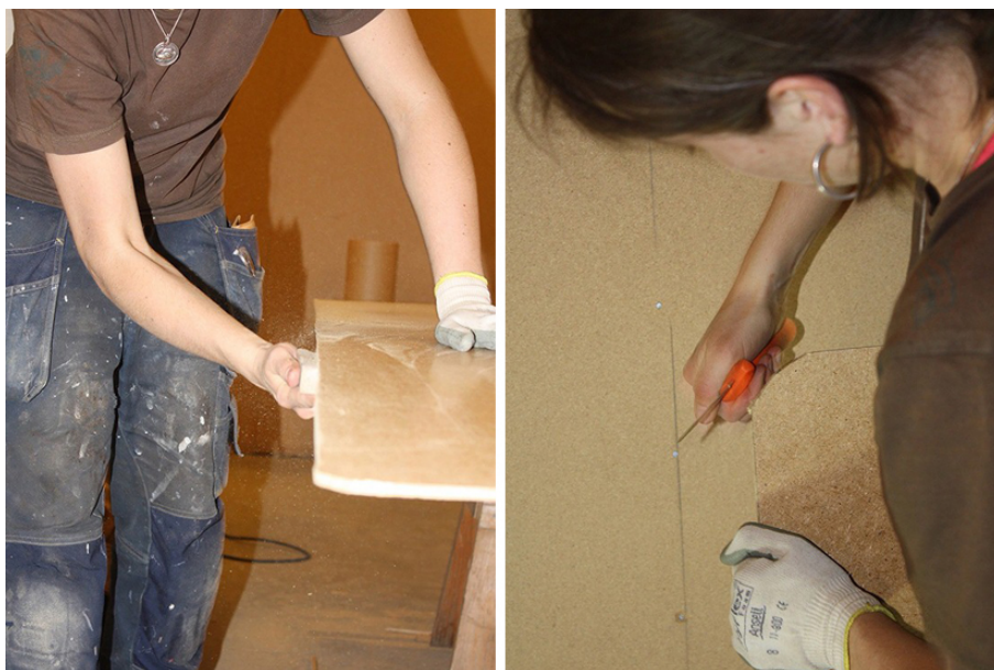
Fig. 71. Vänster: Sandpapper på en putsklots för att avlägsna fnas i kanten. Enligt Bengt-Arne Cramby kan sandpapper repa masoniten så att det även syns efter målning. Detta har dock inte kunnat verifieras eftersom laborationerna inte sträckte sig över ytbehandling/målning. Höger: En vass morakniv fungerade också bra att runda av kanter och hörn med. Foto: Linda Andersson.
