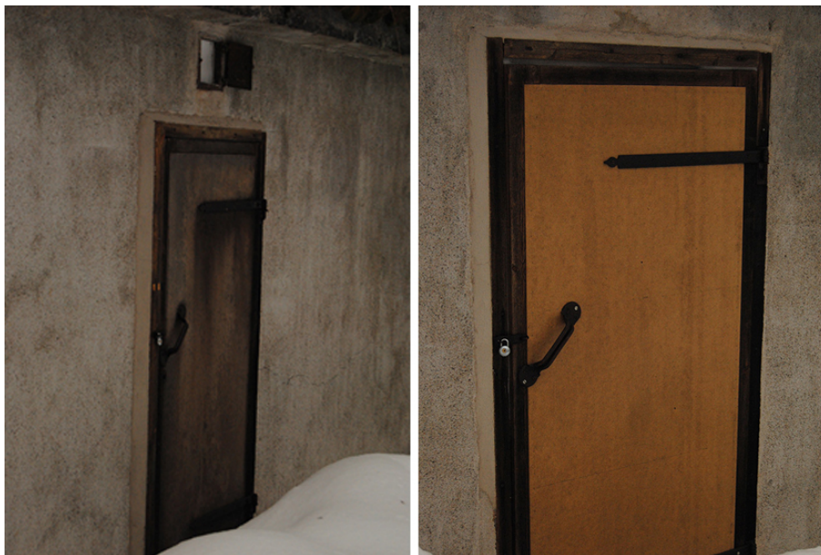
Fig. 30. Dörrar i obehandlad masonit till en ekonomibyggnad på Olofsfors bruk. Masonit har använts både obehandlad och målad, som fasadmaterial och ibland även som tak.
