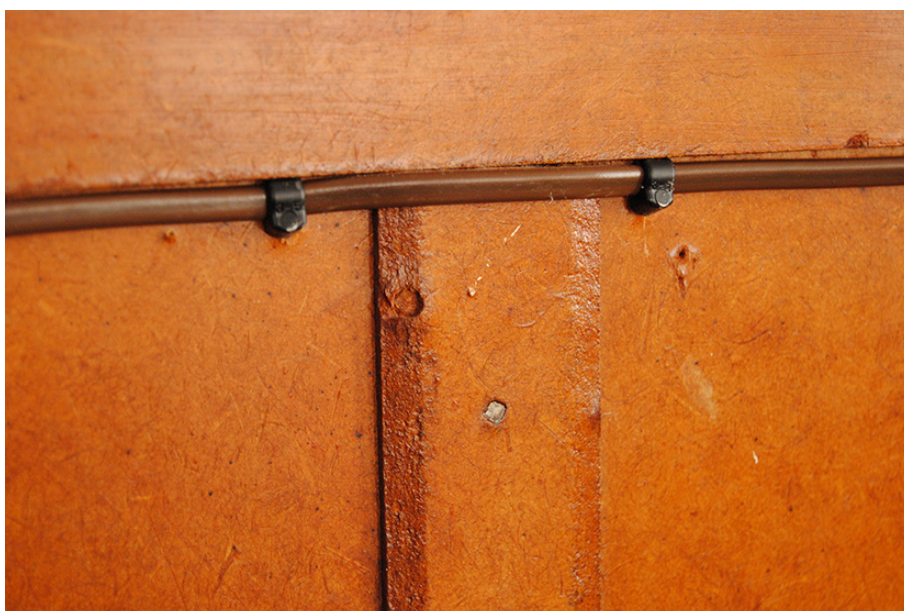
Fig. 23. Förstoring av dekorationslist på boasering, även den av masonit, som satts över skarven. Masoniten är spikad med dyckert. Kanterna är fasade med en hyvel, men det går inte att säga säkert vilken.
