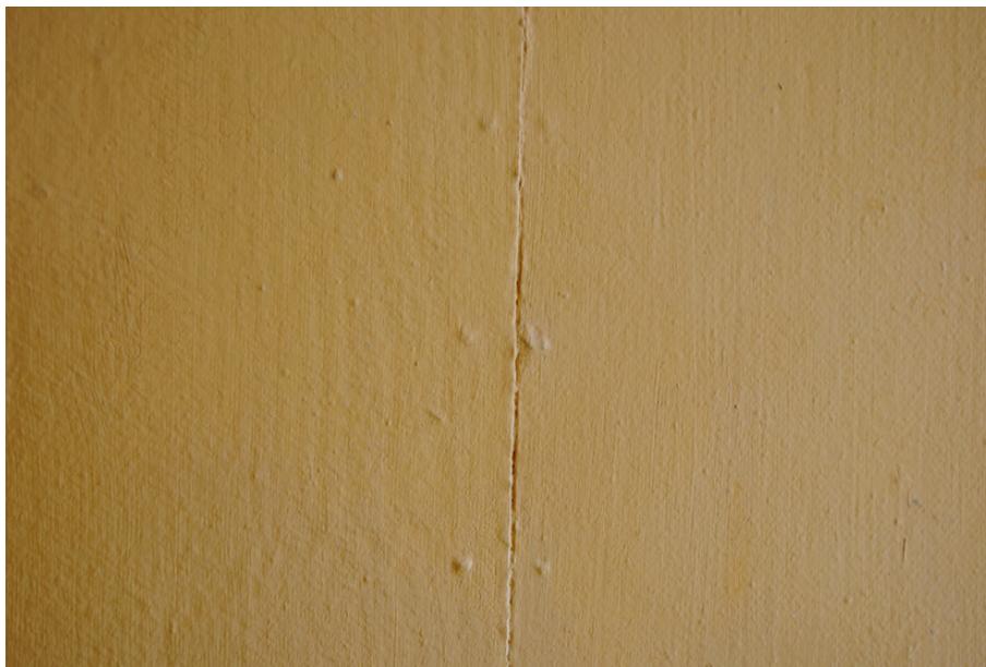
Fig. 39. Närbild av väggen i fig. 38. Skivorna är spikade tätt med ca 5 cm mellanrum och har hållit sig släta.
