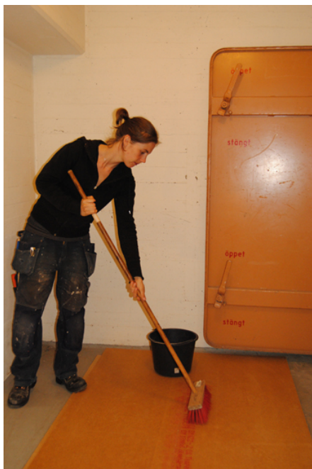
Fig. 43. De stora skivorna till monteringen vattnades med hink och piassavakvast. Vattnet skvättes ut och det var lättare att styra mängden vatten jämfört med vattenkannan.
