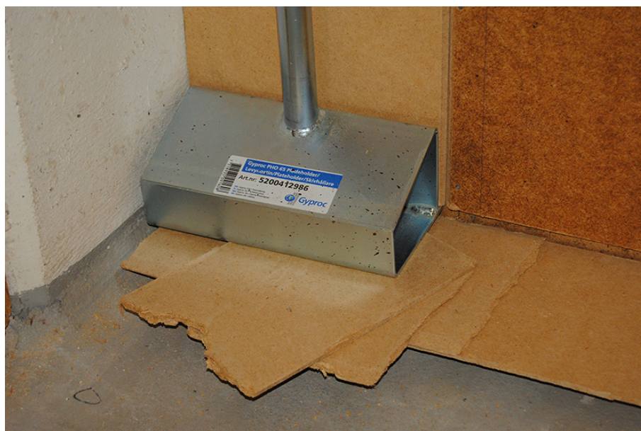
Fig. 75. Det mest problematiska med skivhållaren var efter skivan anpassats till vägg och tak och skulle tryckas upp mot taket för att smita tätt. För att skapa ett tryck stoppades småbitar in under skivhållaren.
