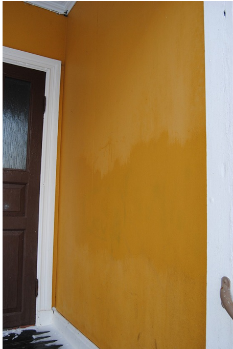
Fig. 38. Vegg under tak som är målad med linoljefärg, Rundviks skola. Väggen är slät och välbevarad.
