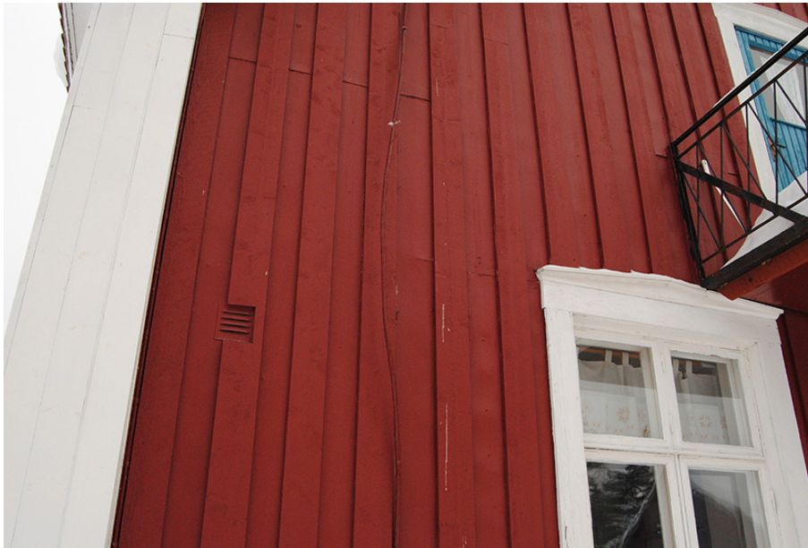
Fig. 34. På Lennart Olofssons hus syns de horisontella skarvarna i skivorna som är karakteristiska för hus med fasad av masonit.
