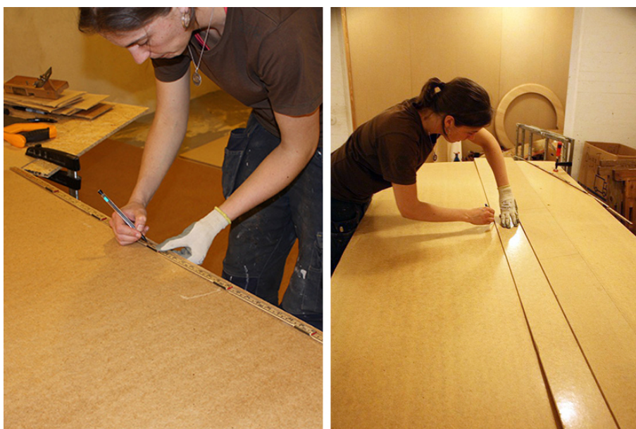
Fig. 69. Vänster: Tumstock och penna är bra att mäta ut mitten och spikavstånd med. Höger: Linjalen kan användas för att dra raka linjer med. Det fungerar att dra spiklinjer när skivan är monterad på vägg också, ifall vattenpass används. Foto: Linda Andersson.
