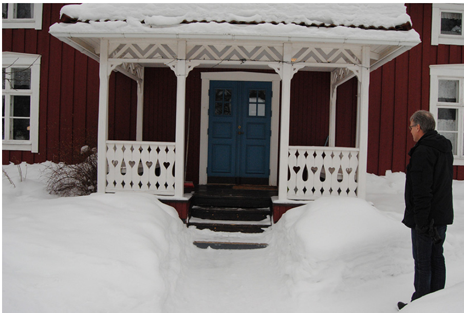
Fig. 33. Lennart Olofssons hus i Mo. Huset hade ursprungligen träpanel som någon gång bytts ut mot masonitskivor med lockläkt. När Lennart köpte huset och skulle renovera det kompromissade han såtillvida att lockläkten togs bort och byttes ut mot lockpanel för att sträva efter att återlikna originalpanelen av trä. På bilden: Lennart Olofsson.
