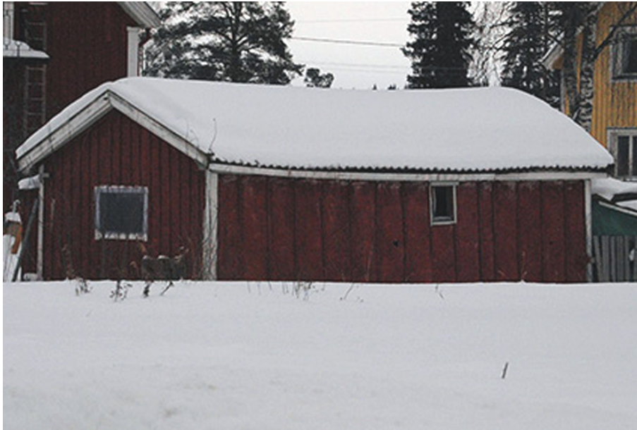
Fig. 32. Ekonomibyggnad i Mo, grannby till Olofsfors bruk. Byggnaden är målad med röd slamfärg.
