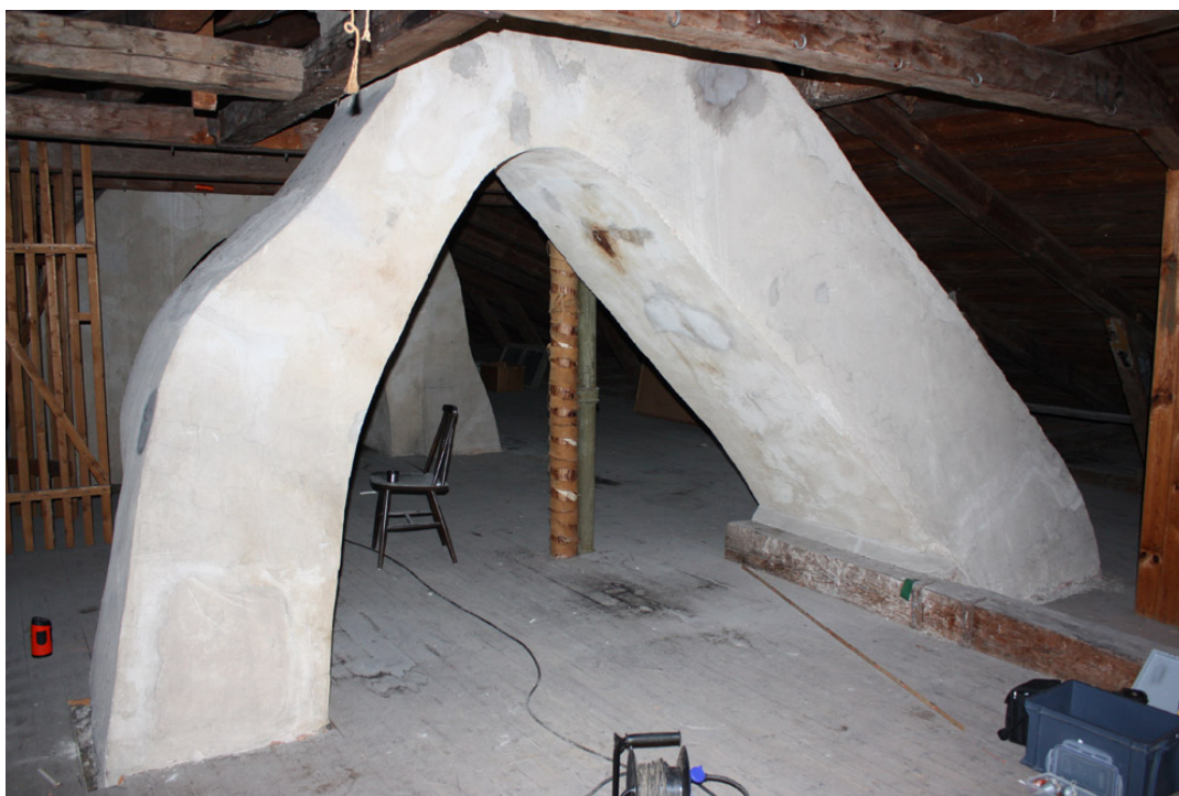
Fig. 40. Byxben 1. Överst i bild syns avvaxlingen av takstolen. Den vänstra murstocken gör en avvikande krök.
