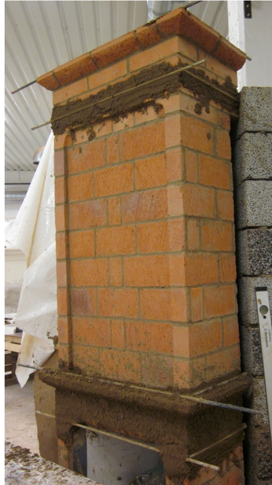
Fig. 3. Rörspisen med hylla och krön förberedda för listdragning.
