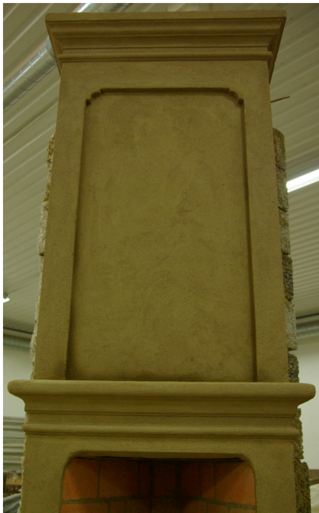
Fig. 5. Den lerbruksputsade rörspisen med schablondragna listverk på hyllan och krönet.
