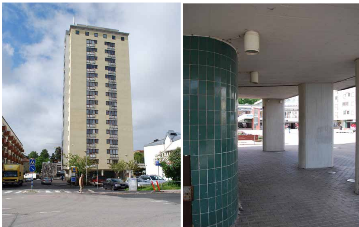
Bild 20 & 21: Punkthuset och dess pelarkonstruktion.
