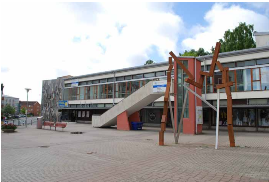
Bild 10: Axel-huset med den ursprungliga trappan och den tillbyggda hissen.
