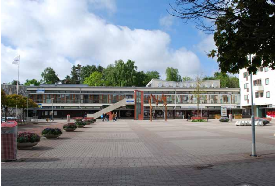
Bild 9: Axel-huset med fasaden mot torget.
