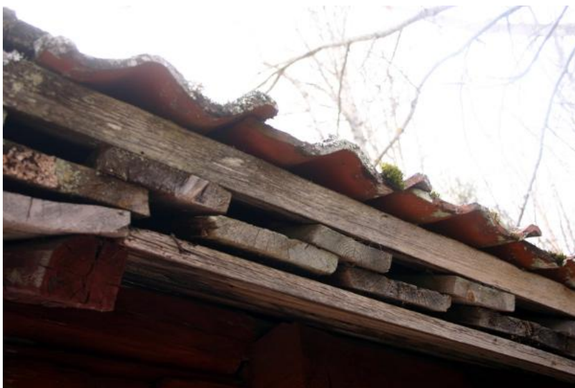
Bild 23 Brädtak skymtas under teglet.
