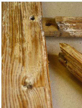
Figur 81 Rak och vinklad spröjs möter bågstycke.
