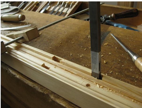
Figur 110 Tapphålen huggs för hand i fönsterbågen.
