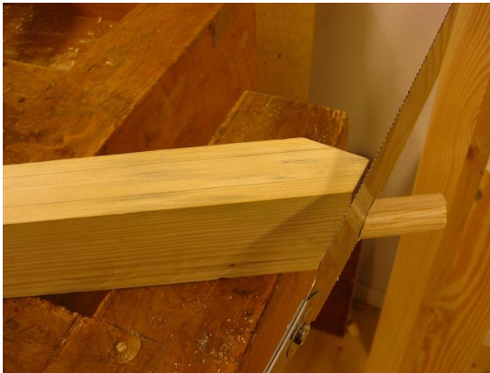
Figur 185 Överskottsmaterial sågas bort.
