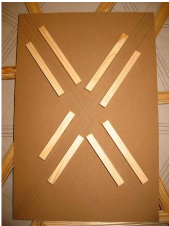
Figur 149 Små lister limmas intill markeringarna för spröjsens dimension.
