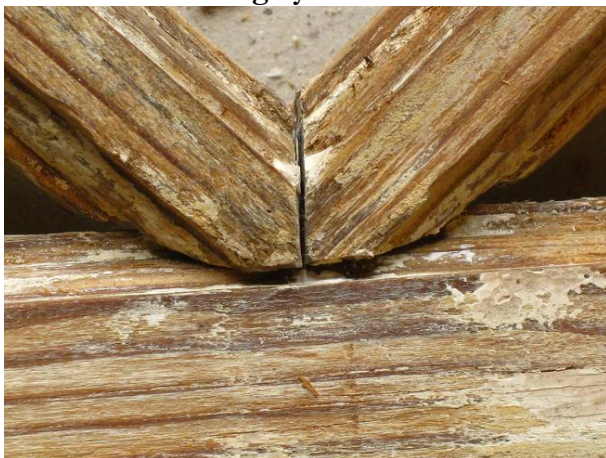
Figur 78 V-möte mot bågstycke.
