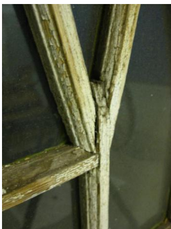
Figur 83 V-möte mot 90 graders "hörna".
