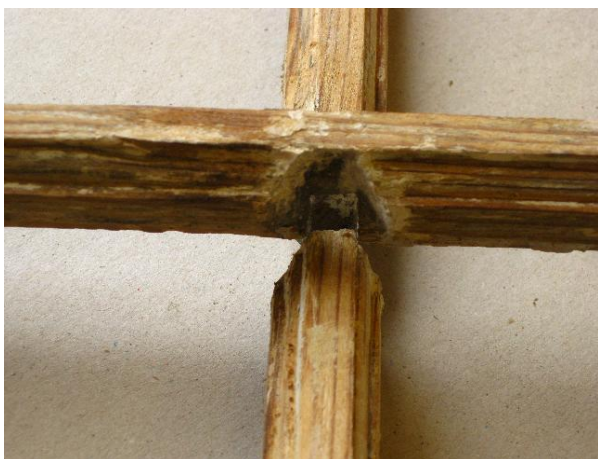
Figur 59 Spröjskryss 90 grader.
