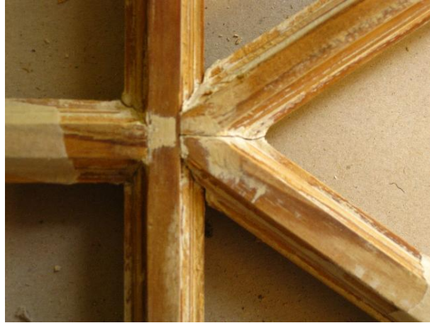
Figur 73 V-möte möter T-möte.
