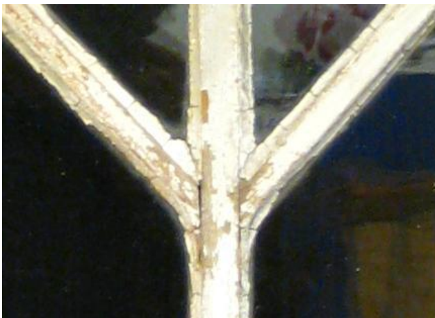
Figur 90 Vinklade spröjs möter en grov spröjs.
