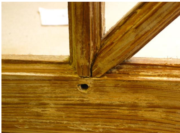
Figur 82 Rak och vinklad spröjs möter bågstycke.
