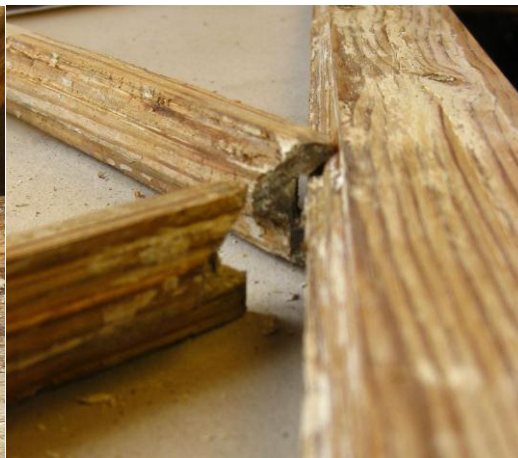
Figur 79 V-möte mot bågstycke.
