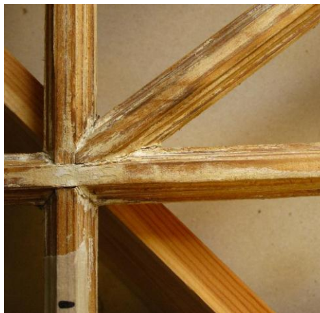
Figur 80 Vinklad spröjs möter 90 graders spröjskryss.
