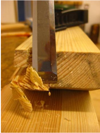
Figur 154 Spröjsens ände skärs till.
