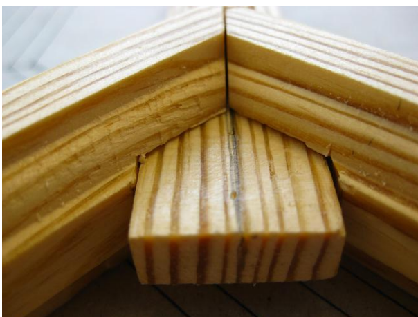
Figur 194 Närbild på tapp och slits.
