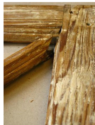
Figur 75 Spröjs möter hörn i fönsterbåge med kontraprofil.
