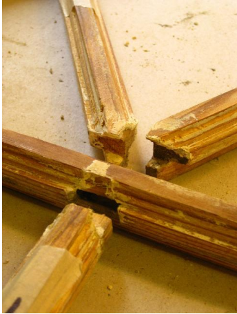
Figur 72 V-möte möter T-möte.
