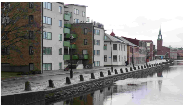
Bild 6. Exempel på kajskoning längst med Åvägen.
