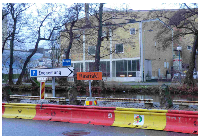
Bild 17. Avspärrning av Ävägen på grund av rasrisk.
