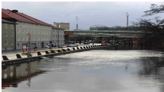
Bild 16. Utsikt över Ävägen och dess landhövdingshus. Observera lutningen på kajskoningen.
