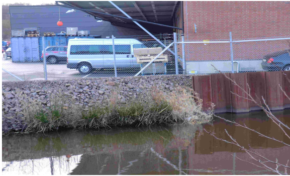
Bild 8. Här ser vi en vallning och en stöttning av järn.
