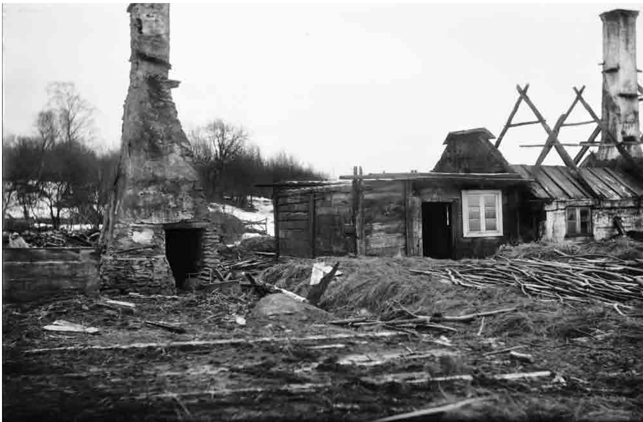
Fig. 54. Näsgården vid rivningen i Västra Göinge, Skåne, år 1900. Gårdens egna murstockar står ännu kvar som solitärer i landskapet. Gårdsägarens son Nils Jönsson beskrev skeendet 1949: "Danskarna vältte ikull skorstenarna efter rivningen. Jag vill minnas, att en stenmur lades av de flata stenarna i muren." Foto: Johanne Andersen, 1900. Frilandsmuseets arkiv, Nationalmuseet i Köpenhamn.
