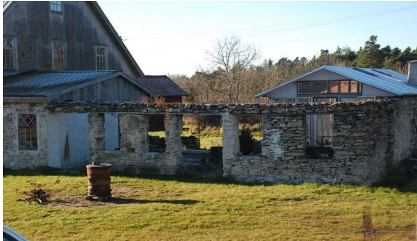
Figur 99: Foto av ruinen och växthuset utanför ladan.
