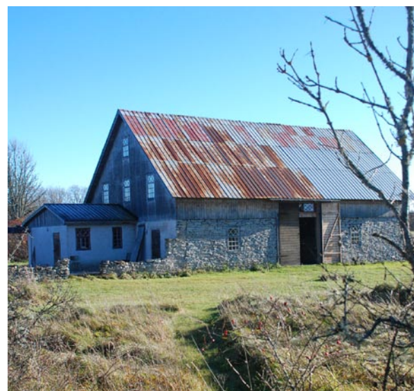
Bild 4: Den ombyggda ladan med gästrum etc.
