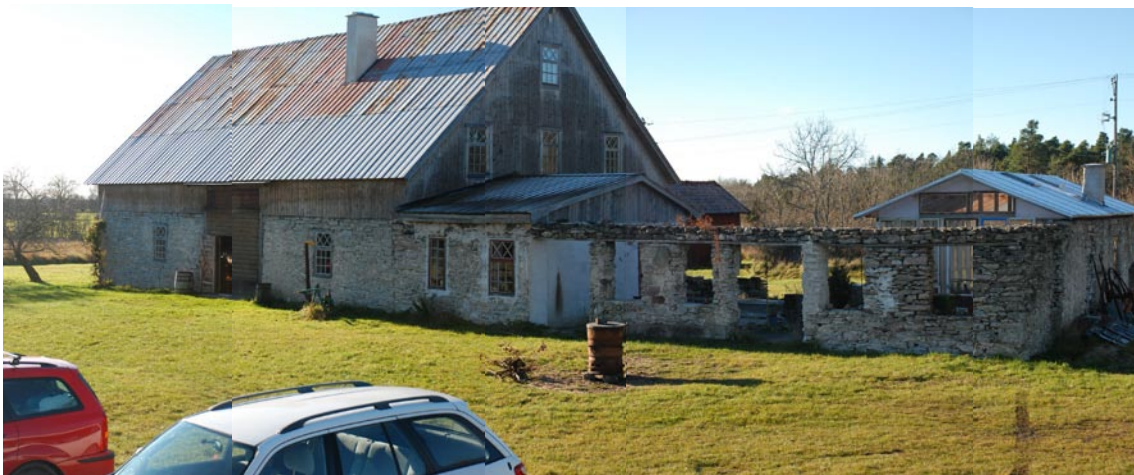
Figur 3: Den ombyggda ladan med en stor ateljé och sovrum på övervåningen samt matsal, kök och garagedel på bottenplan.
