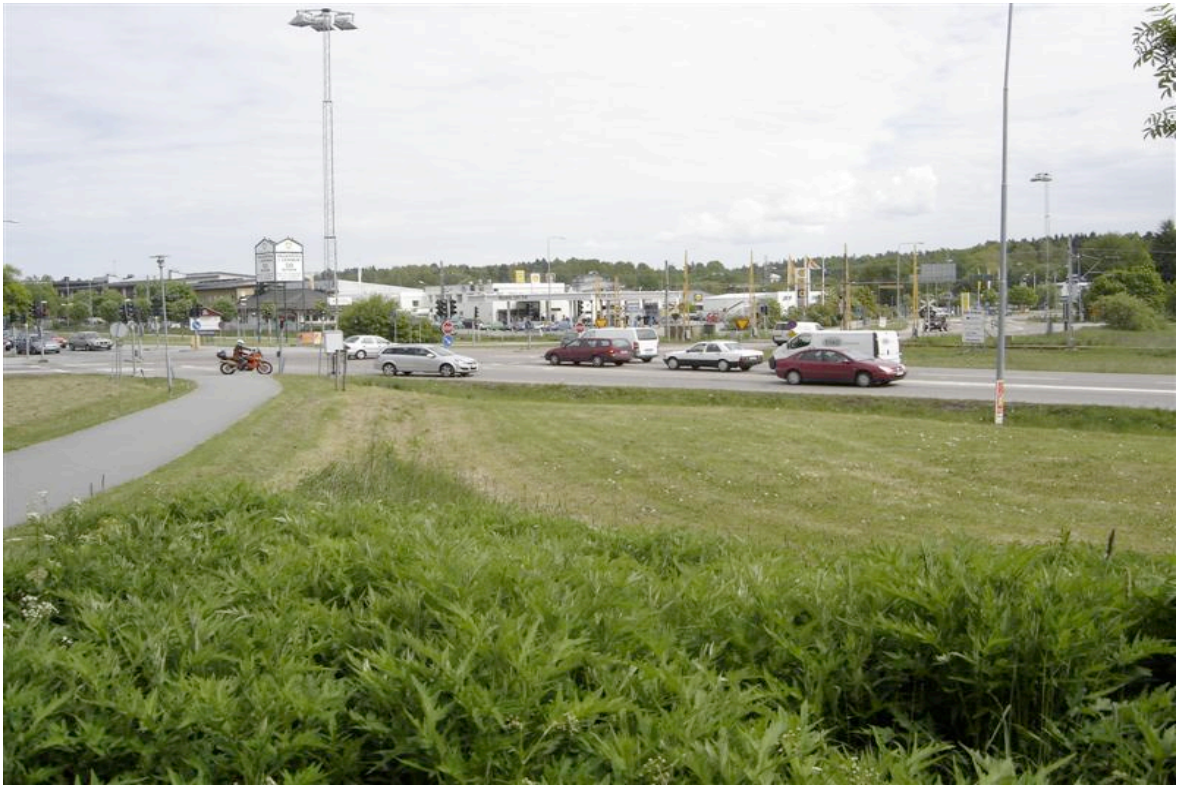
Trafikplatsen från sydväst.
