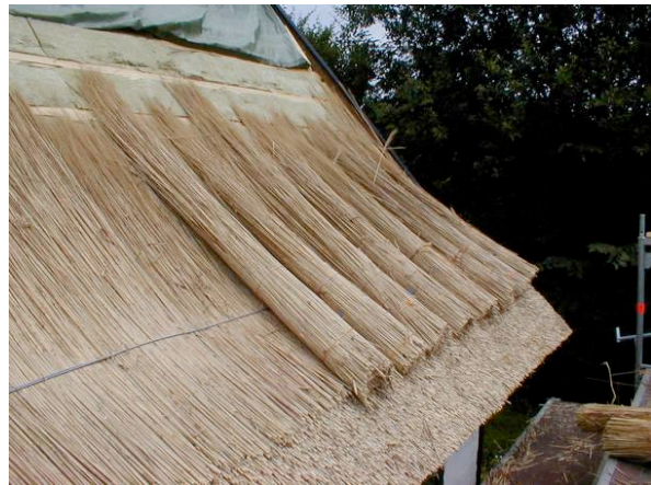
Taktäckning med elefantgräs (S. Vodder)
