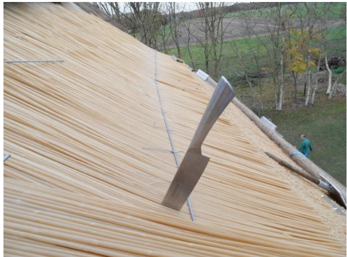
Foto på taktäckning med konstvass (B.
