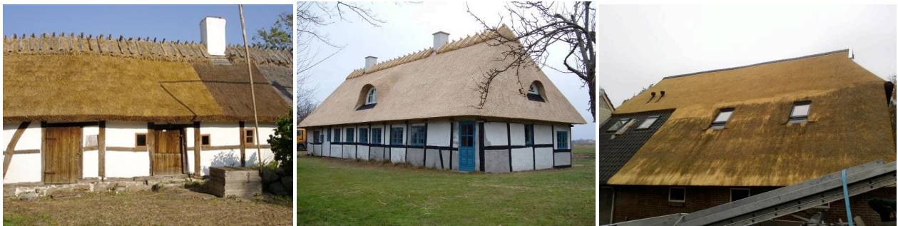
Foto på ett halmtak (bild Kalle Melin), elefantgrästak (bild Søren Vodder) och konstvasstak (bild Bart Verhoek).
