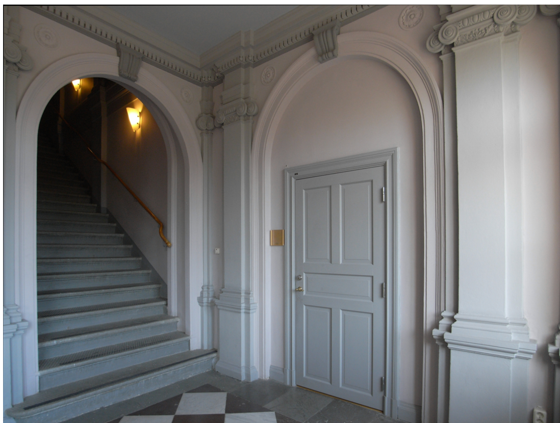
Figur 10. Centraltrapphuset innehåller, tillsammans med kyrksalen, byggnadens mest välbevarade interiörer. Veggstuckaturer hämtade från nyrenässansens formvärld och mönsterlagda stengolv av kalksten är ett uttryck för den unga sinnessjukvårdens ambitiösa strävanden.
